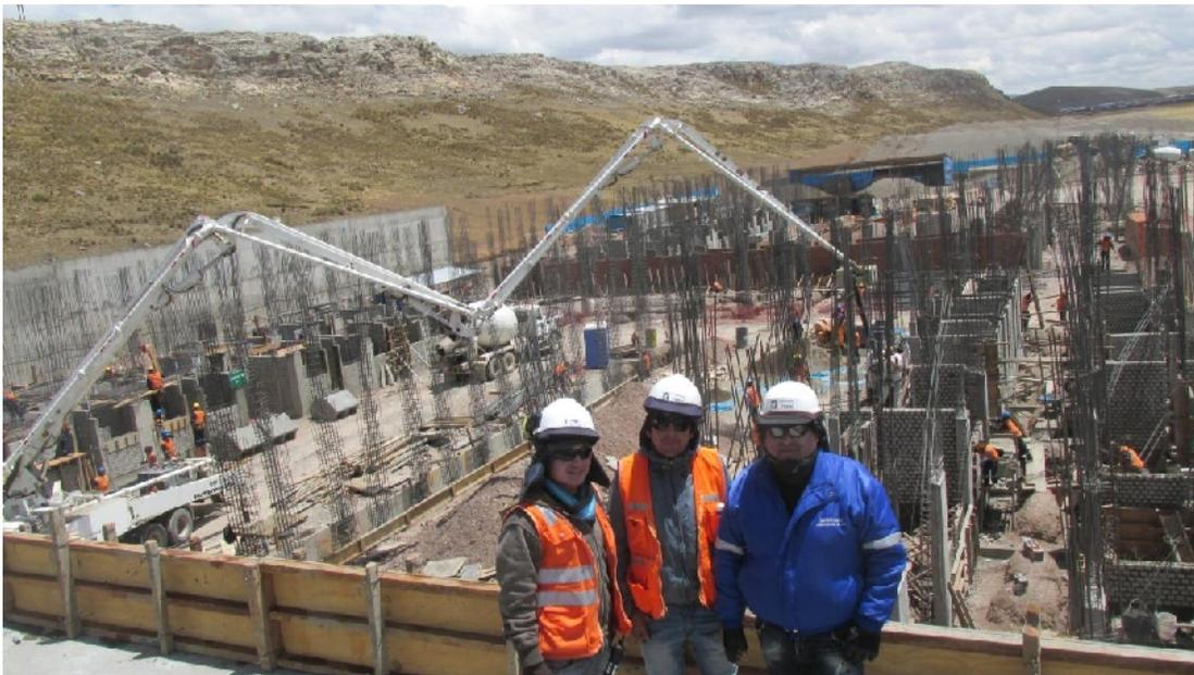
Fotografía N° 16: Supervisión de Trabajos en el vertido de concreto en columnas, con la bomba Pluma.
