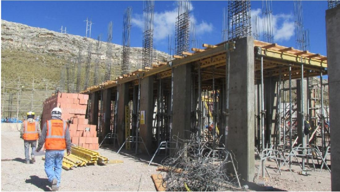
Fotografía N° 11: Encofrado de losa aligerada en Venustierio de RCE
