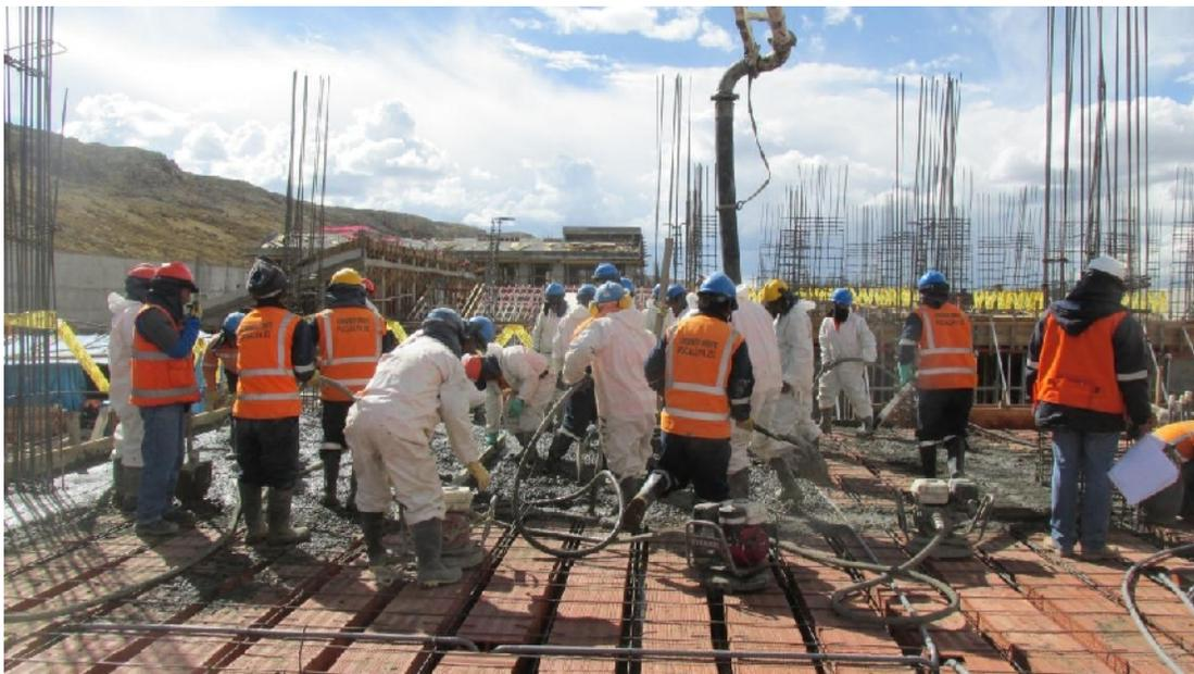
Fotografía N° 18: Mala distribución de Personal en vaciado de concreto en techos, Significado de Tiempo No Contributorio
