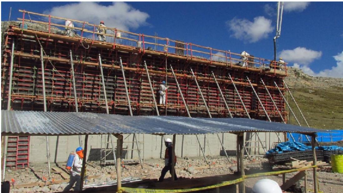
Fotografía N° 10: Vertido de concreto en Cerco Pasarela segundo Nivel Alcanzando la Altura de H= 7.50m.
