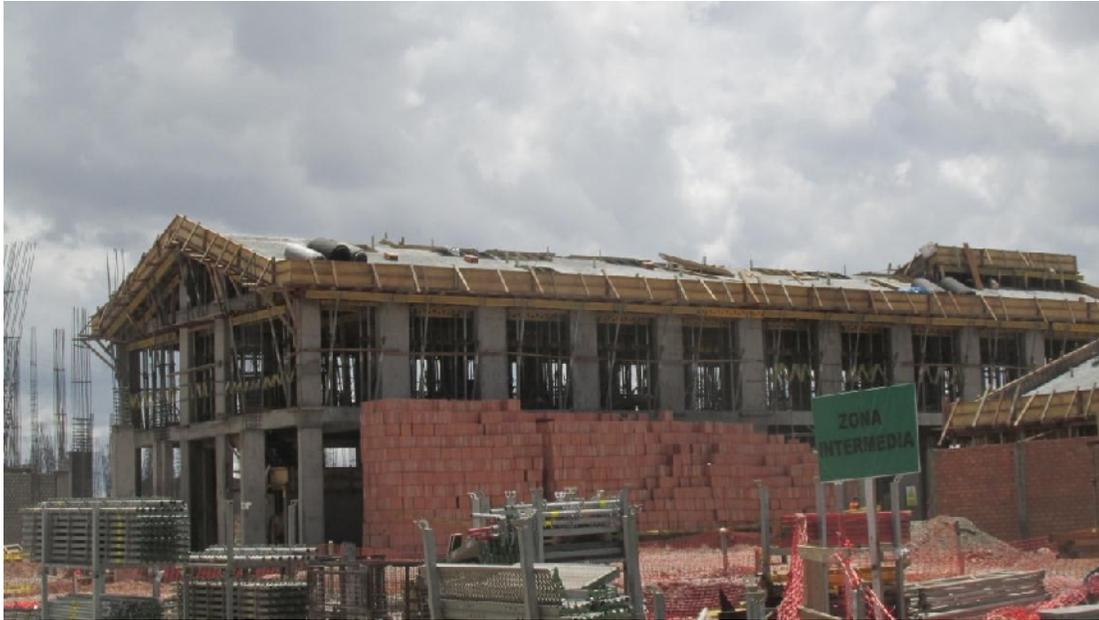
Fotografía N° 17: Acabado Final luego del vertido de concreto en el segundo techo del Venustero de RCE
