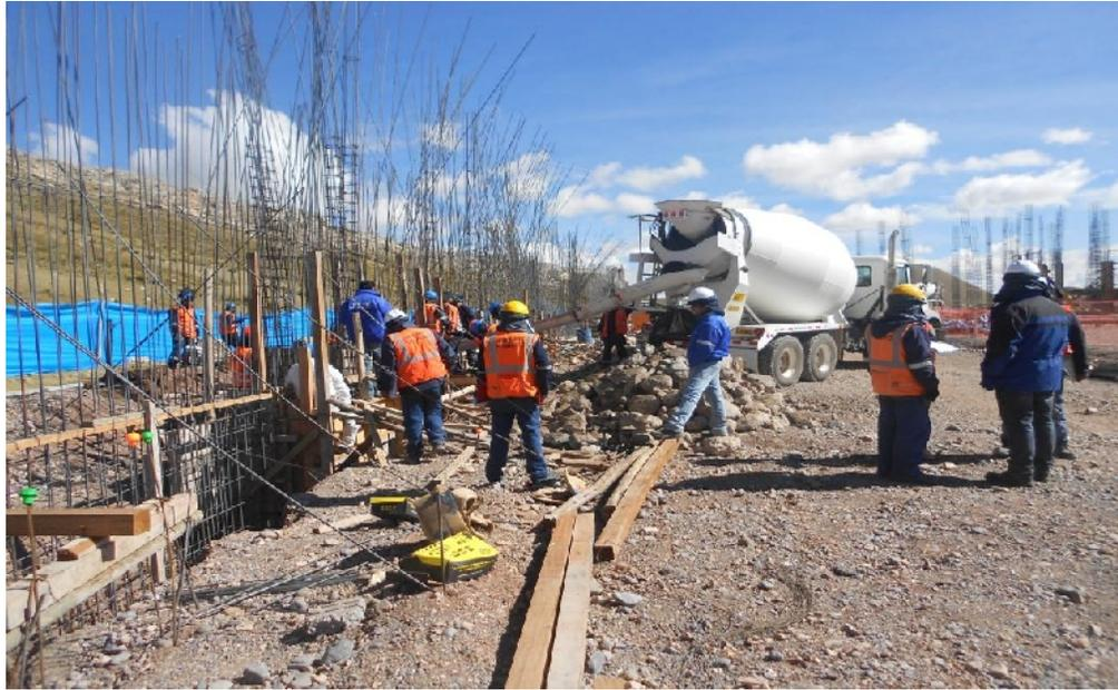
Fotografía N° 09: Verificación de los trabajos en campo en la partida Vertido de Concreto en el cerco Pasarela.
