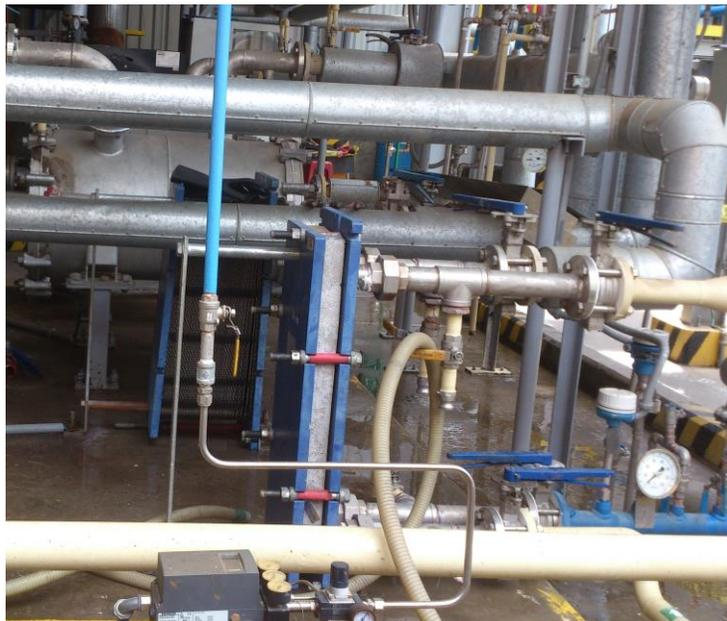
**Fotografía N° 04:** Intercambiadores de calor
