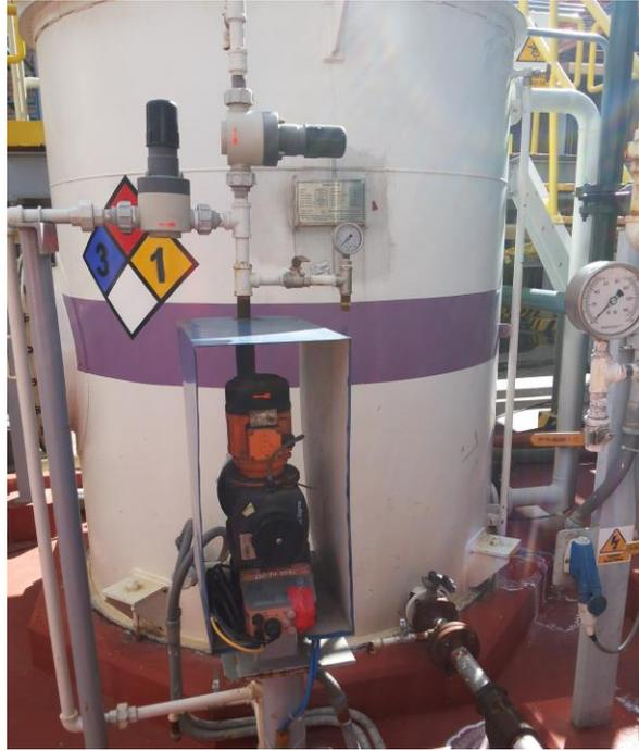
**Fotografía N° 03:** Tanque de preparación de NaOH
