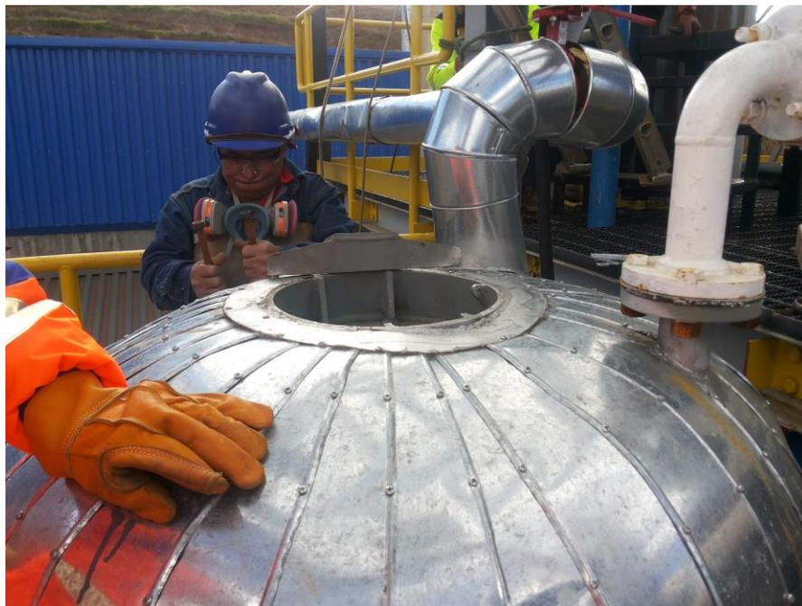
**Fotografía N° 02:** Brida superior lugar de carga de carbón fino
