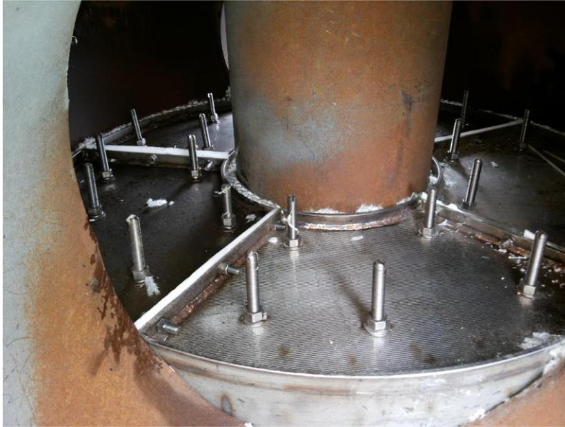
**Fotografía N° 01:** Mallas superiores del reactor de desorción.
