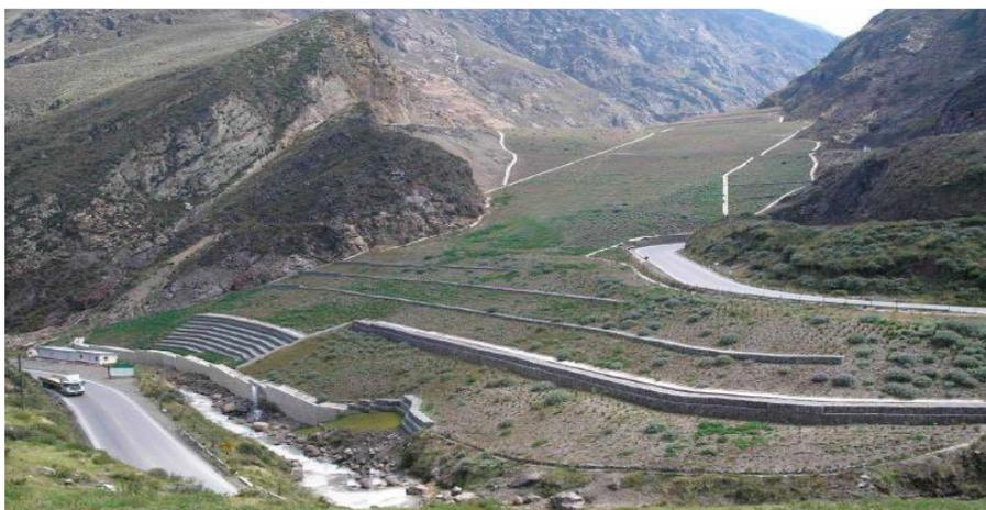
Figura 25. Vista del depósito de relaves de Tablachaca, después del cierre con encapsulamiento y revegetación.
