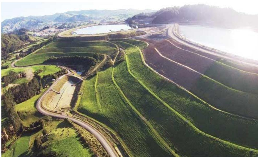
*Figura 34.* Vista del depósito de relaves de una mina en Nueva Zelanda, después del cierre con encapsulamiento y revegetación.
