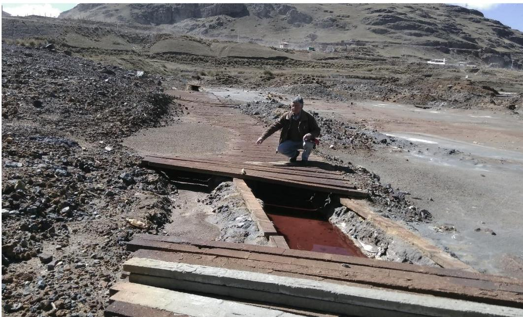
Canal interceptor de aguas ácidas del desmonte Excélsior
