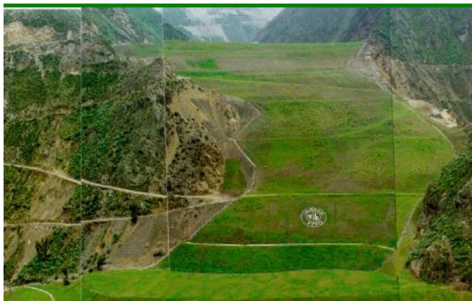
*Figura 29. Vista del depósito de relaves de Yauliyacu, después del cierre con encapsulamiento y revegetación.
