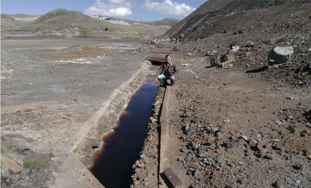
Canal de recolección de aguas ácidas al pie del talud de desmontes Excélsior
