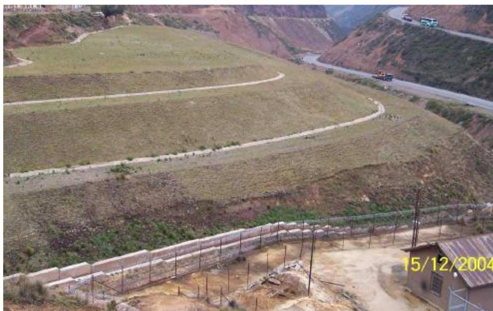
*Figura 27.* Vista del depósito de relaves de Casapalca, después del cierre con encapsulamiento y revegetación.
