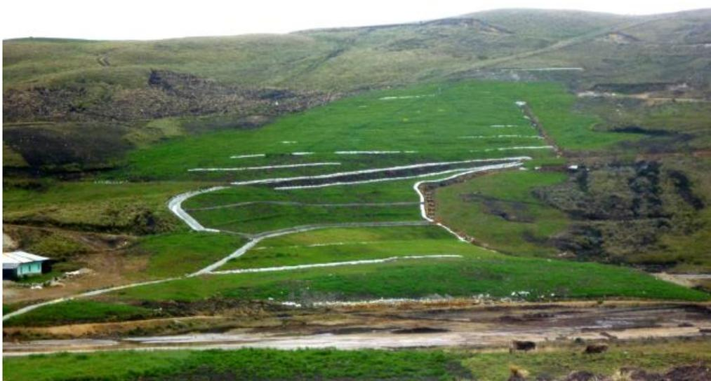
*Figura 31.* Vista del depósito de relaves de Hualgayoc, después del cierre con encapsulamiento y revegetación.
