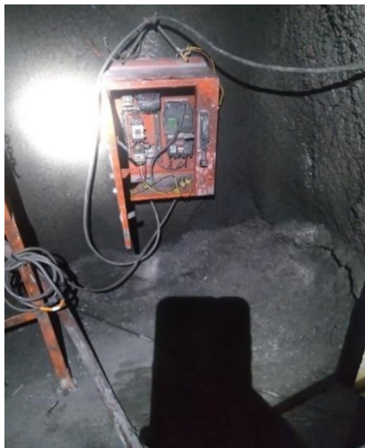
Inspección de TAB eléctricos 440 V
