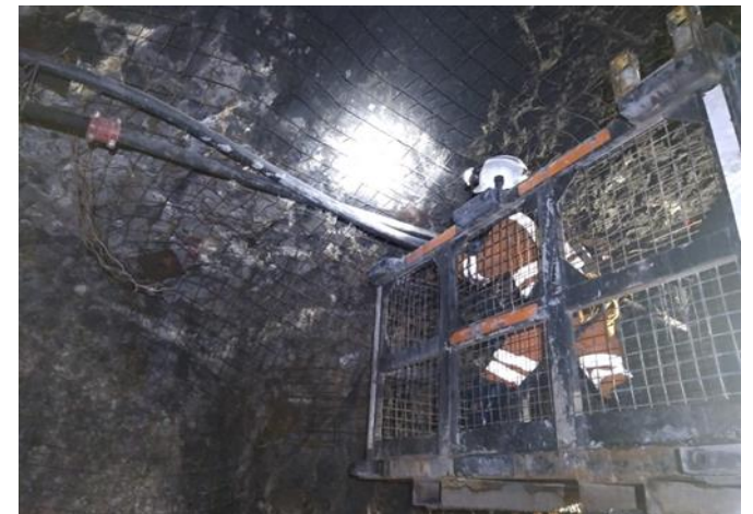
Verificación de controles para trabajos en altura
