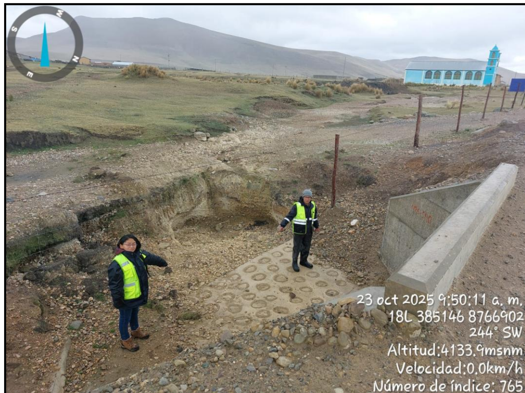
Imagen 4. Vista de la no presencia de caudal en época de estiaje
