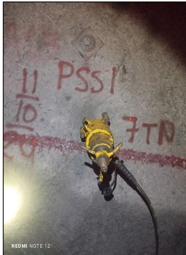
Figura 3. Corresponde a un ensayo de extracción (Pull Test) realizado sobre un perno de sostenimiento tipo Split Set instalado en una labor subterránea
