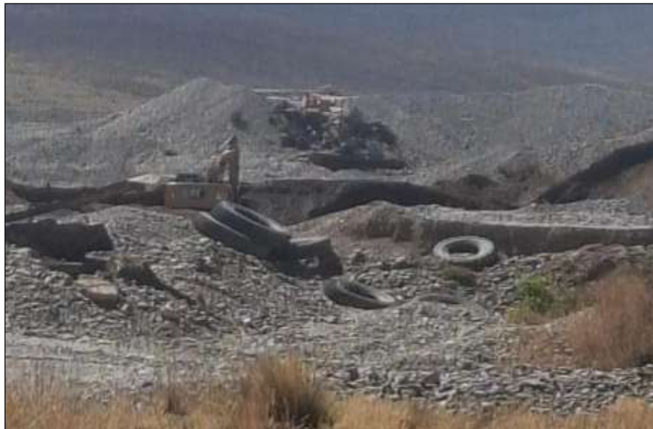
Imagen 2. Extracción de arena y agregados con equipo
