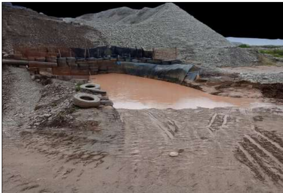
Imagen 9. Infiltración de aguas en las zonas de producción en Vicco
