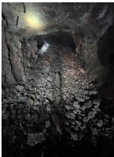
Figura 25. Post Voladura, frente con carga
