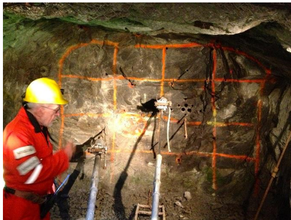
Figura 14. Control de malla de perforacion
