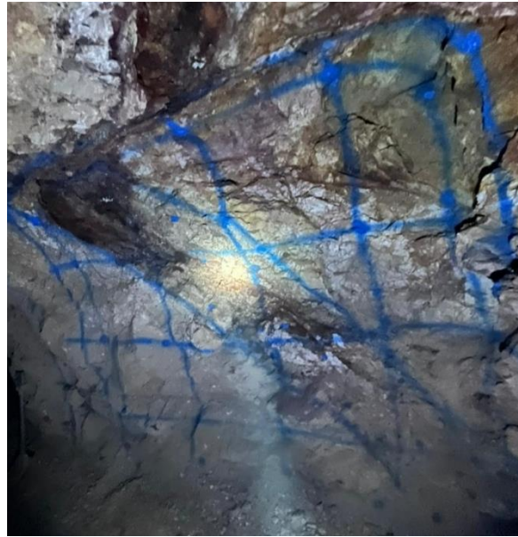
Figura 23. Malla de perforación y voladura diferenciada en campo
