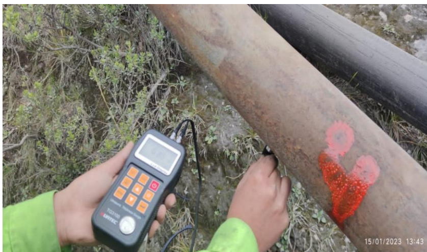
Ilustración 7. Medición de Espesor de las Tuberías
