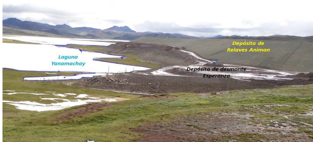
Figura 5. Fotografía de escarpas de erosión 2
