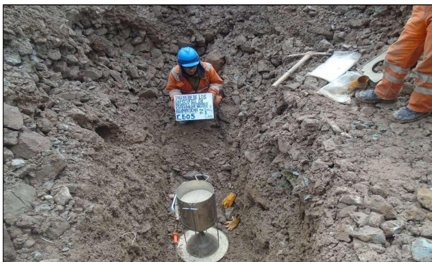
Foto N°10: Ensayos de densidad con cono de arena en la calicata CE-05
