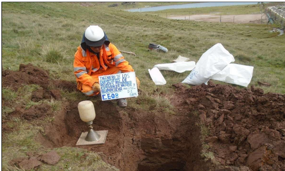
Foto N°16: Ensayos de densidad con cono de arena en la calicata CE-08 En la imagen se observa la densidad D-1 (prof. 0.50 m)
