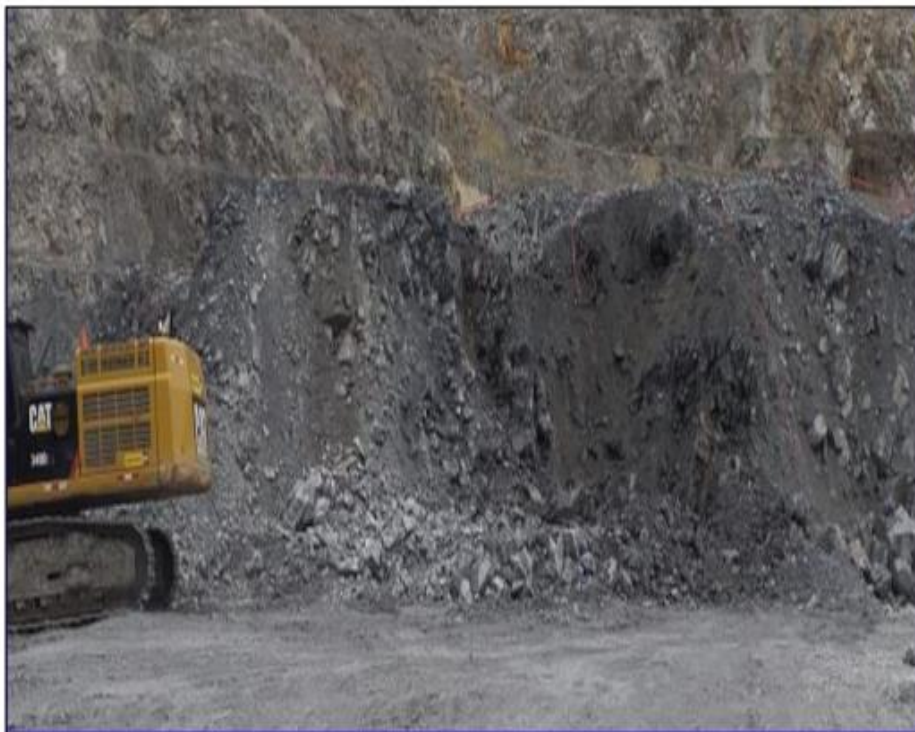
Imagen 06: Carguío con equipo.
