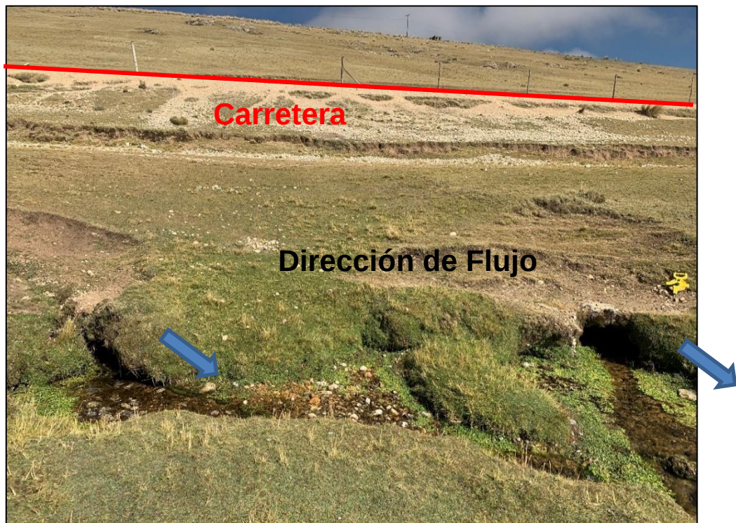
Fotografía 17: Km. 4+700. Descarga de agua de acuíferos kársticos en la zona de Huarmipuerto por debajo de la vía en estudio.
