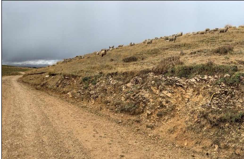
Fotografía 29: rocoso en la progresiva Km 28+040.
