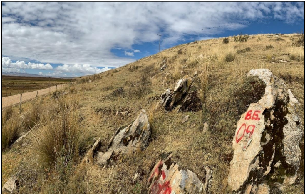
Fotografía 25: Talud rocoso en la progresiva Km 17+290.
