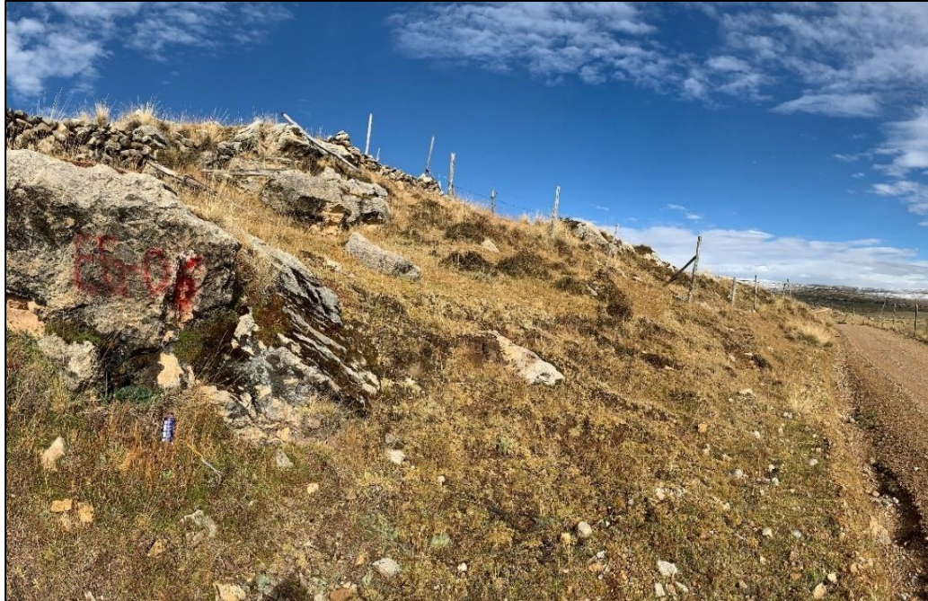
Fotografía 28: Talud rocoso en la progresiva Km 23+640.
