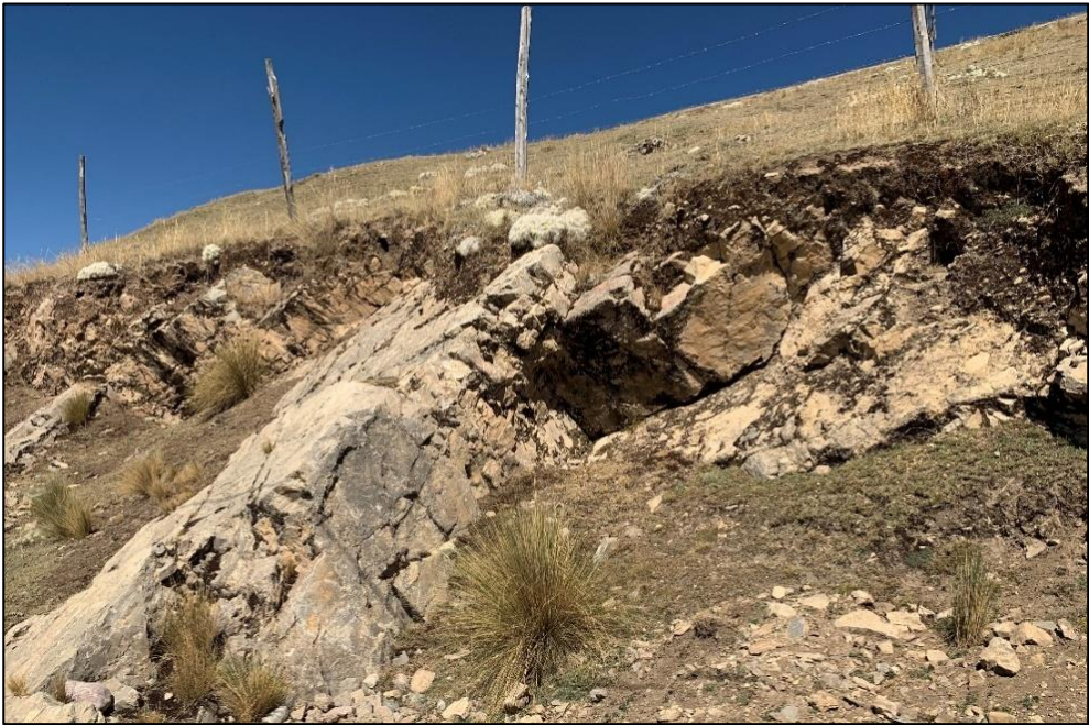
Fotografía 20: Talud rocoso en la progresiva 4+750, con estratos sub paralelos al eje de la vía.
