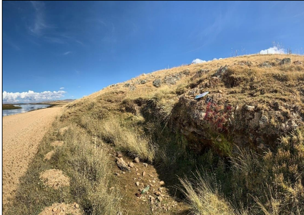
Fotografía 31: Talud rocoso en la progresiva Km 42+280.
