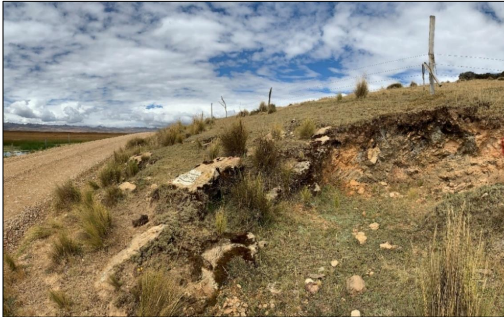
Fotografía 24: Talud rocoso en la progresiva 14+430.
