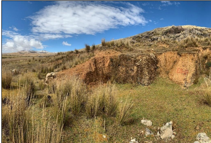
Fotografía 27: Talud Semi-rocoso gradando a suelos residuales en la progresiva Km 21+400.
