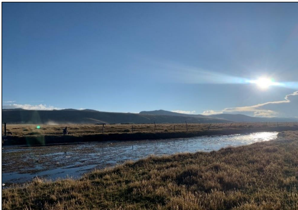
Fotografía 10: Km. 1+840. Depósito lacustre, siendo erosionado por un cauce de agua, Puente Chacachimpa.
