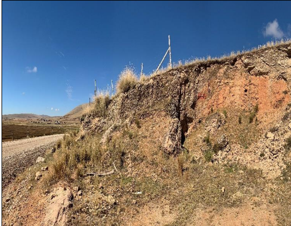
Fotografía 21: Talud en roca frágil en la progresiva 12+240.
