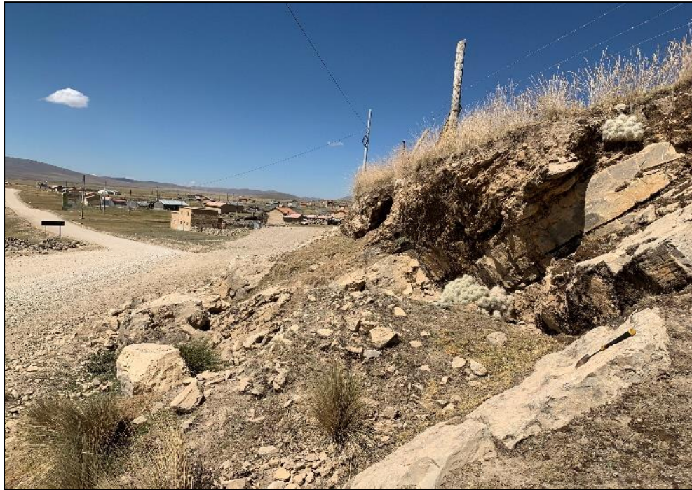
Fotografía 6: Km. 4+700. Afloramiento de Calizas beige y grises de la formación Condorsinga, se visualiza el fracturamiento y plano de estratificación paralelo al eje de la carretera.
