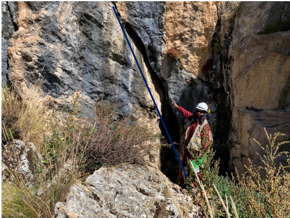
Fotografía 14: Km. 20+860 – 20+900. Zona de falla geológica con apertura de 50 cm en calizas del Grupo Pucará, se logra visualizar el azimuth y buzamiento del plano de falla (azul), Km. 20+860 – 20+900.
