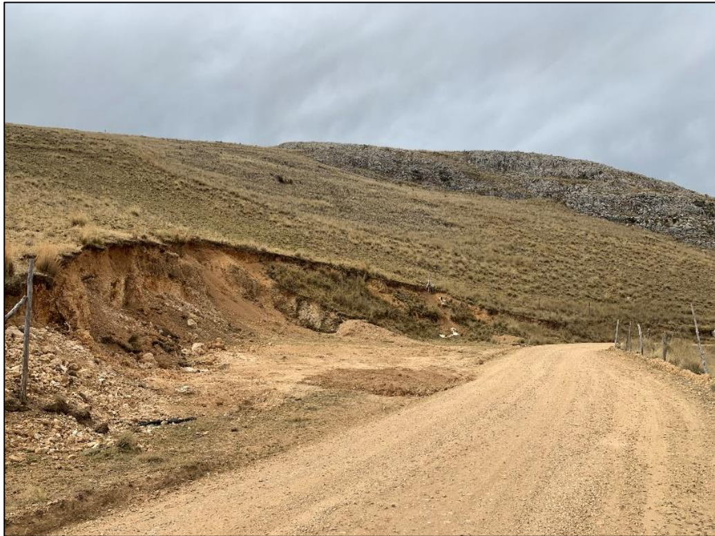
Fotografía 3: Imagen de ladera de pendiente moderada, compuesta de calizas y lutitas, con cobertura de depósitos coluviales.
