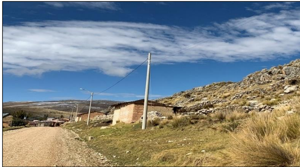
Fotografía 26: Talud rocoso en la progresiva Km 20+460.
