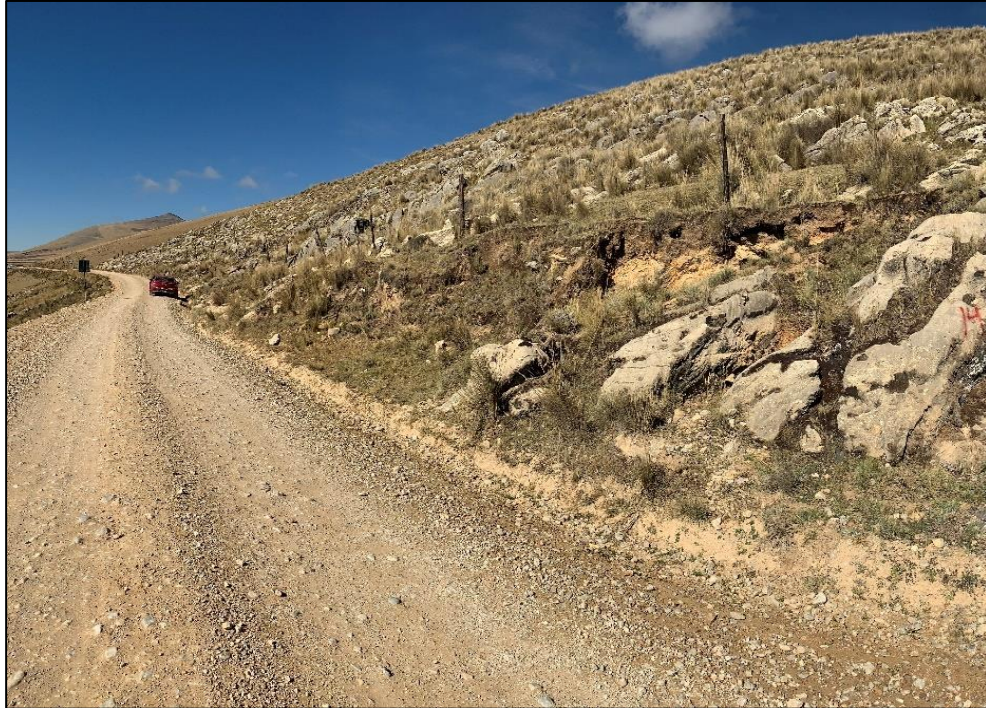
Fotografía 22: Talud rocoso en la progresiva 12+850.
