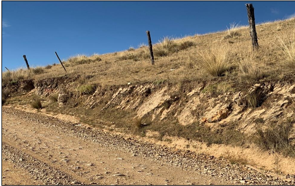
Fotografía 23: Talud rocoso en la progresiva 14+110.
