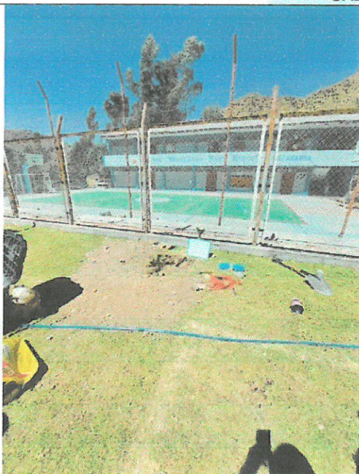
Imagen N°01: Exploración de calicata
