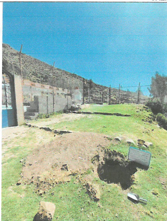
Imagen N°01: Exploración de calicata
