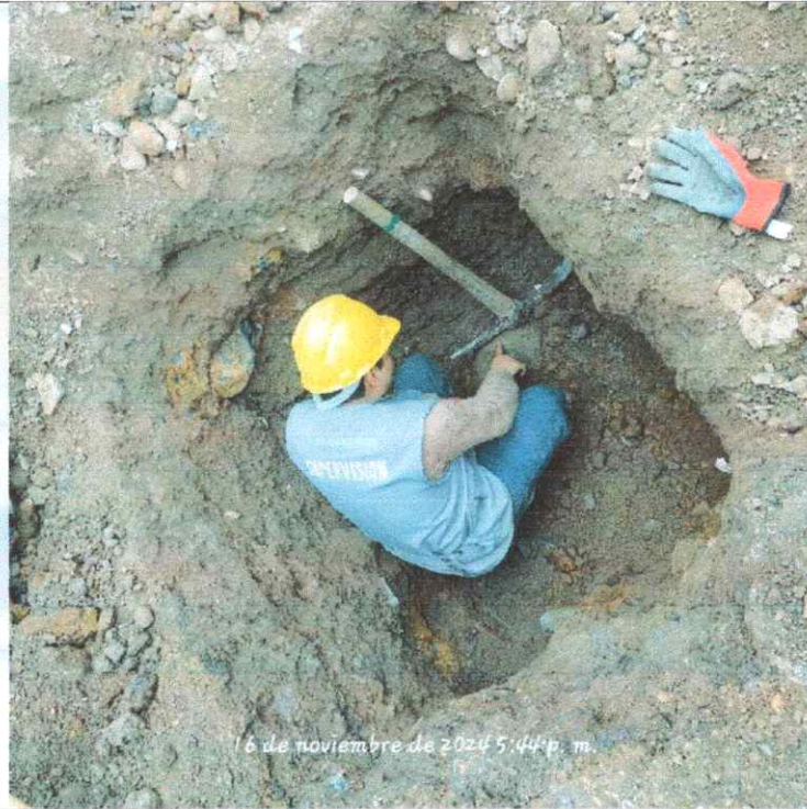
Imagen N°03: Exploración de calicata
