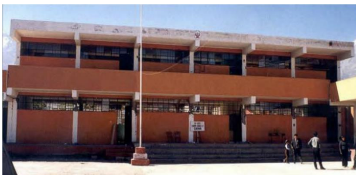
Figura 3. Edificio educativo tipo 780-Pre.
