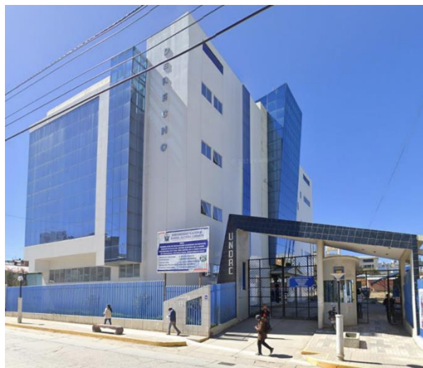
Figura 63. Edificio existente del pabellón de la facultad de Derecho y Ciencias Políticas de la UNDAC.
