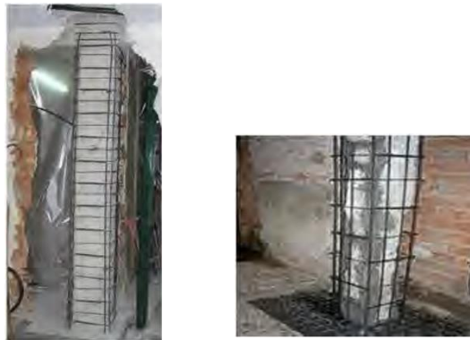
Figura 12. Encamisado de la columna.
