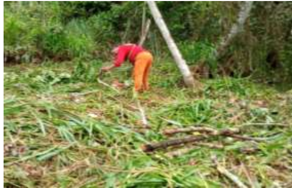
Figura 22. Limpieza y acondicionamiento del terreno
