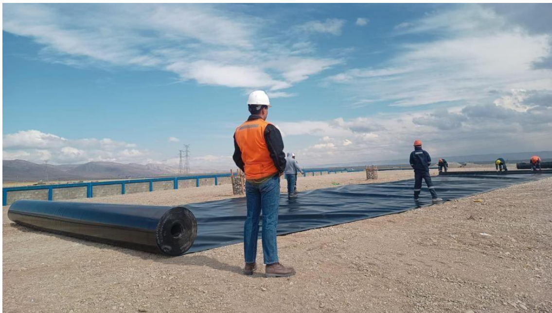
INSTALACION DE GEOMEBRANA
