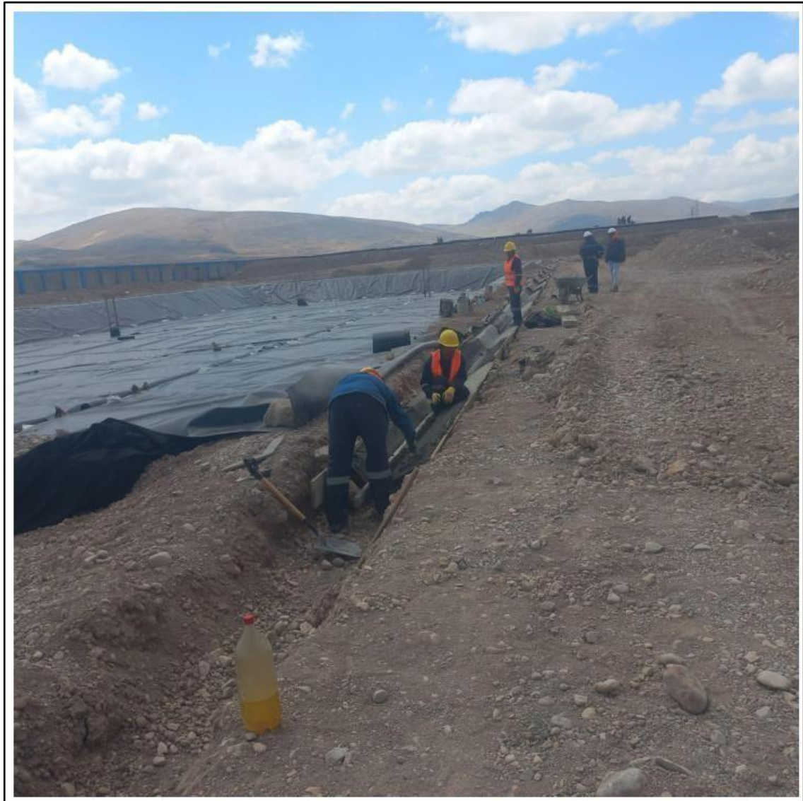
CONSTRUCCION DE CUENTAS EN LA CELDA N°02
