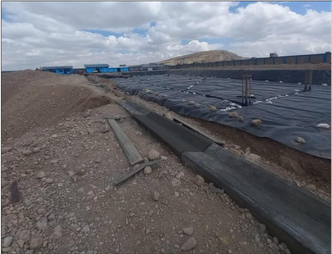
CONSTRUCCION DE CUNETAS E INSTALACION DE GEOMEMBRANA
