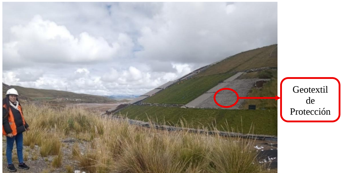
Figura 12 Colocación de Geotextil de Protección
