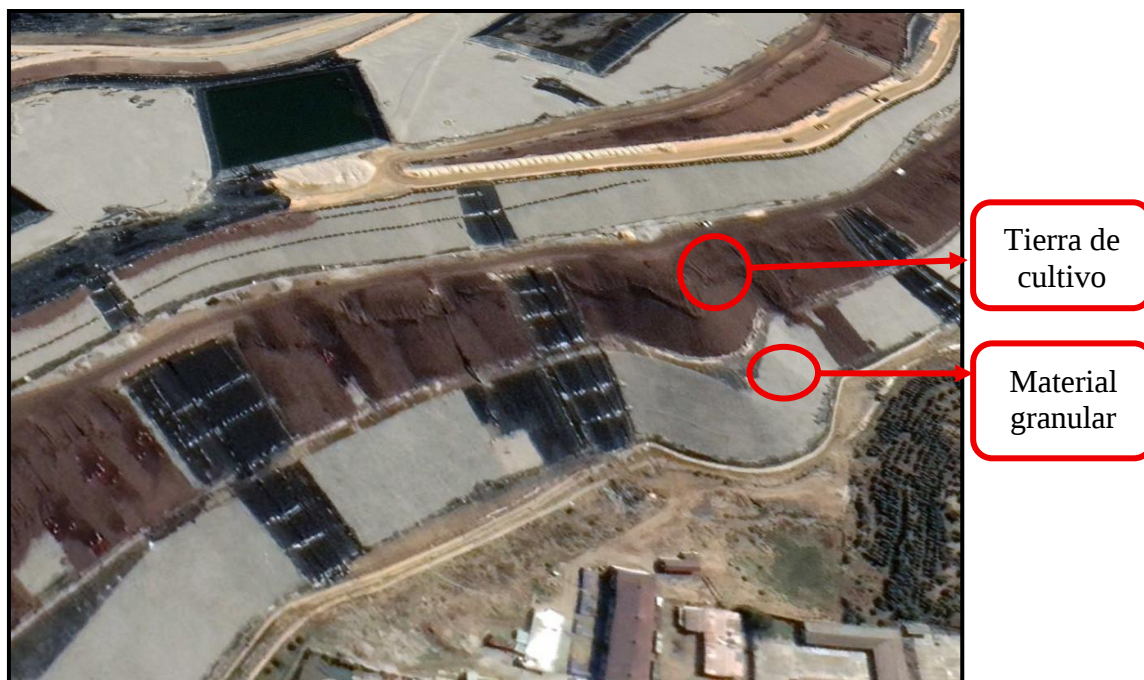
Figura 11 Colocación de Material granular
