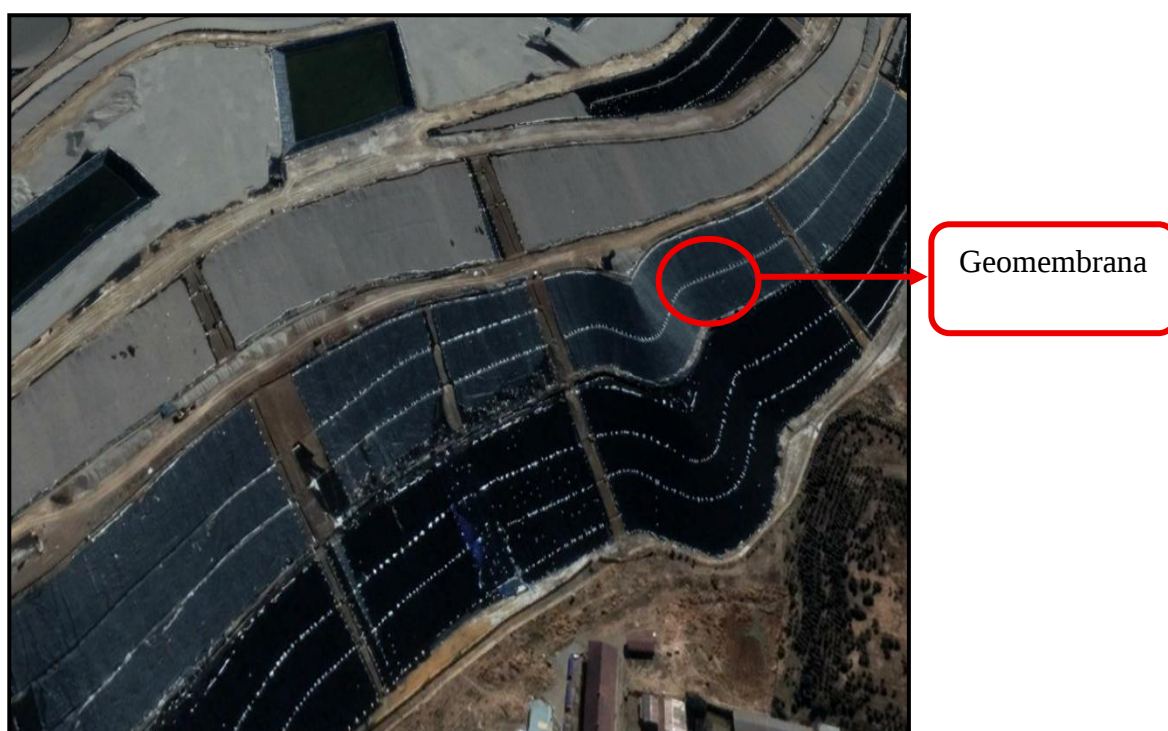
Figura 10 Colocación de Material Impermeable
