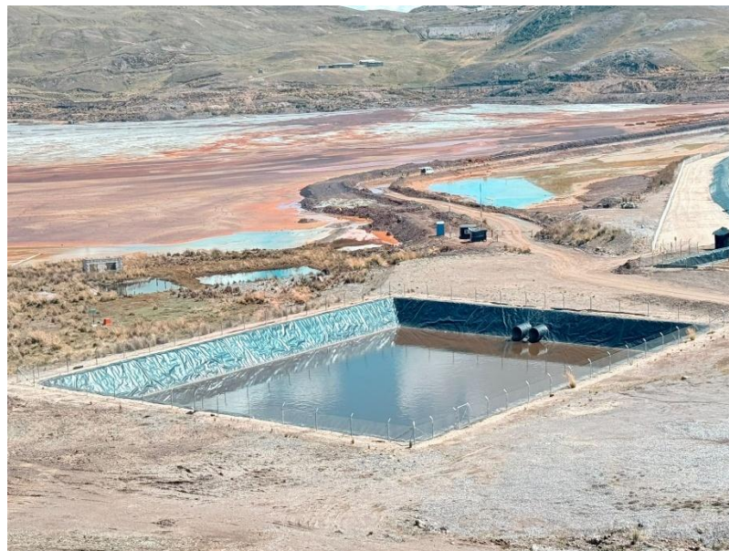
Figura 16 Pozas de almacenamiento de agua
