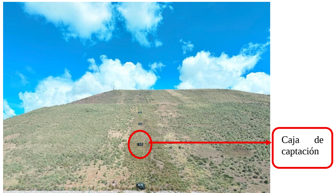
Figura 15 Caja de captación
