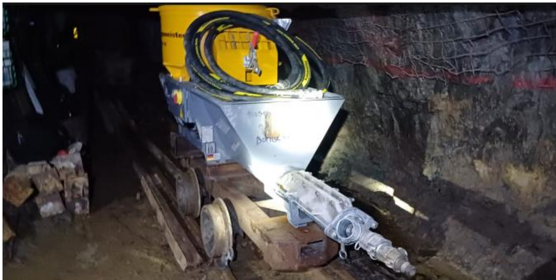
Figura 25 Equipo Putzmeister para inyectado de lechada de cemento a los taladros del cable bolting
