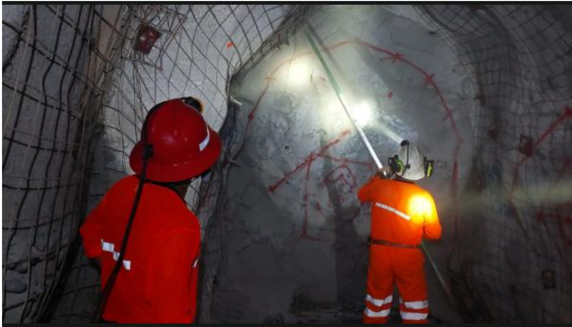
Figura 16 Personal lanzando shotcrete en la galería 9888-S
