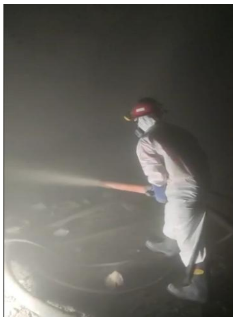
Figura 16 Personal lanzando shotcrete en la galería 9888-S
