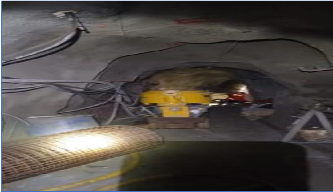
Figura 26 Sostenimiento con cable bolting con el proceso de perno perforado, perno inyectado
