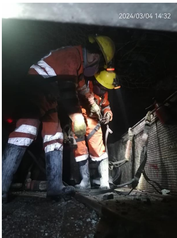
Figura 62. Marcado de Chimenea de 1.20 x 2.40 m y 2.00 x 2.00 m de Doble Compartimiento
