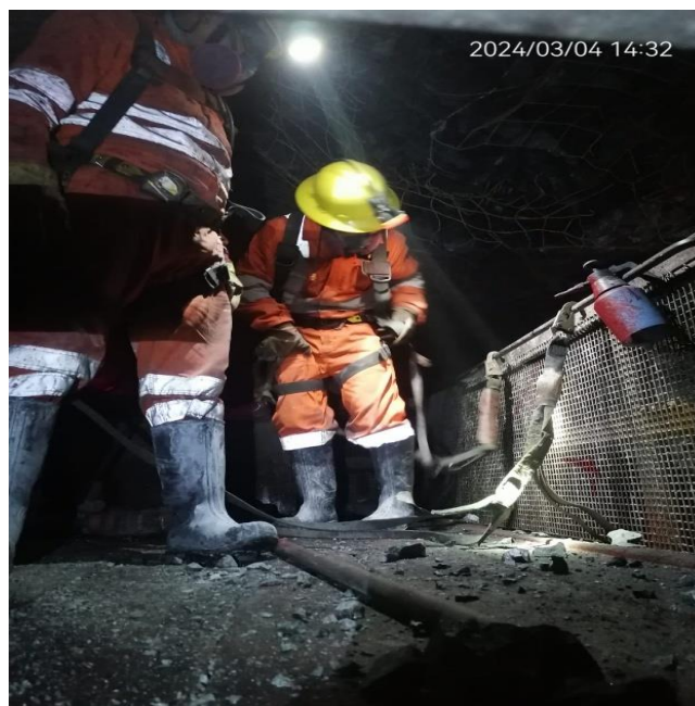
Figura 64. Colocación de Puntales de Madera en Chimeneas por el Método Convencional
