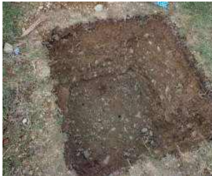
Foto 20. Calicata N° 07, excavación a 1.10 m de profundidad a partir de ahí se tiene material cantos rodado con grava limosa de alta compacidad
