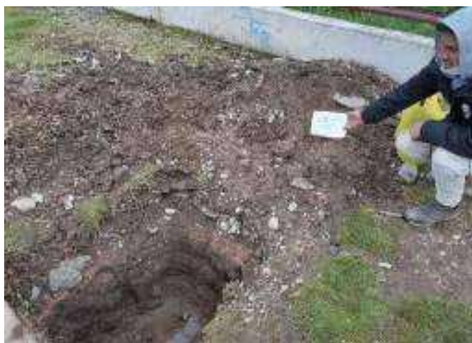
Foto 16. Vista panorámica de la exploración a base de calicata C-06
