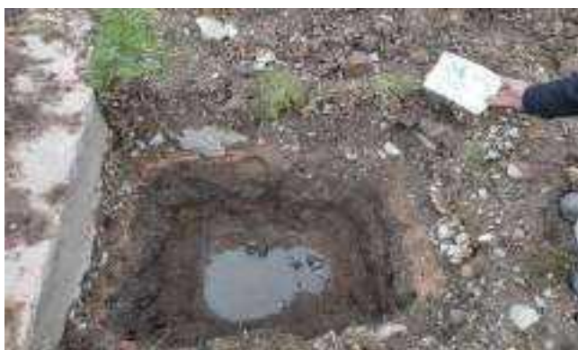
Foto 17. Calicata N° 06, excavación a 1.10 m de profundidad a partir de ahí se encuentra agua en la fecha de investigación
