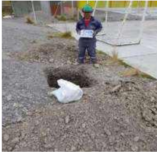
Foto 13. Vista panorámica de la exploración a base de calicata C-05
