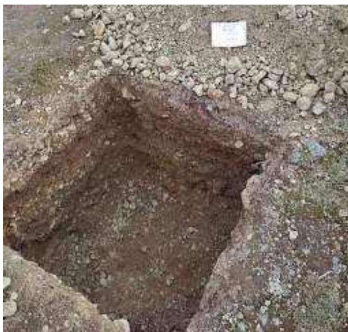
Foto 23. Calicata N° 08, excavación a 1.20 m de profundidad, a partir de ahí se tiene material cantos rodado con grava limosa de alta compacidad
