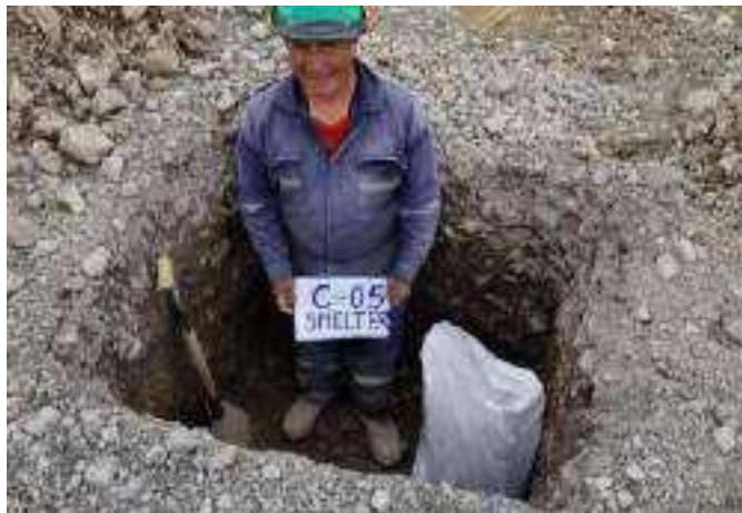
Foto 14. calicata N° 05, excavación a 1.30 m de profundidad
