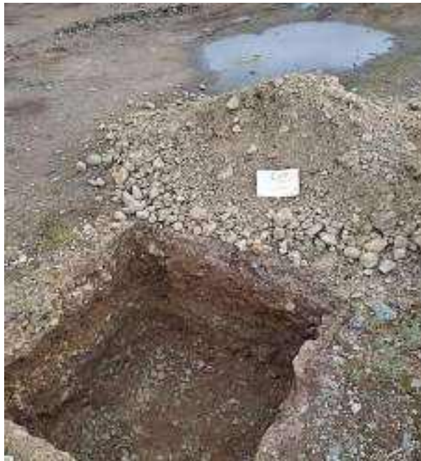
Foto 22. Vista panorámica de la exploración a base de calicata C-08
