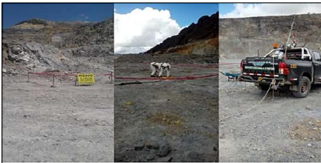
Figura 29. Carguío de taladros con conexión a vacío.
