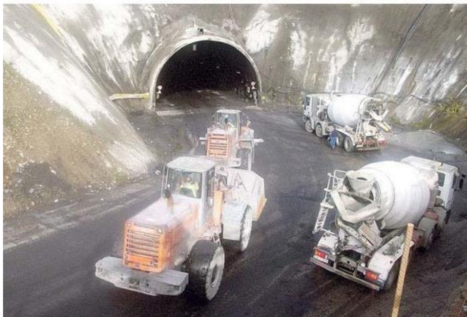
Figura 4. Túnel de ingreso a la mina
