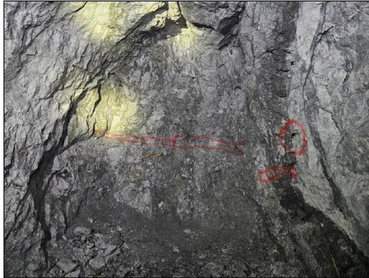
Figura 16. Veta-falla Vanessa con una brecha mineralizada en la caja piso.
