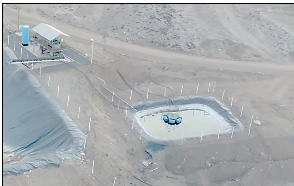
Figura 2 Poza de efluente cianurado
