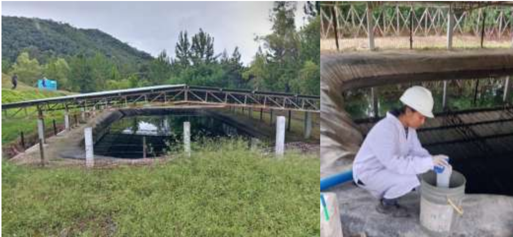
Foto E5. Pozos de lixiviados activos de relleno sanitario de Oxapampa (RSL-01)
