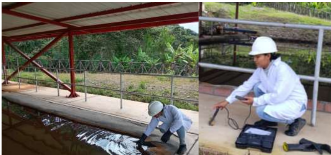
Foto E6. Pozos de lixiviados pasivos de relleno sanitario de Oxapampa (RSL-02)
