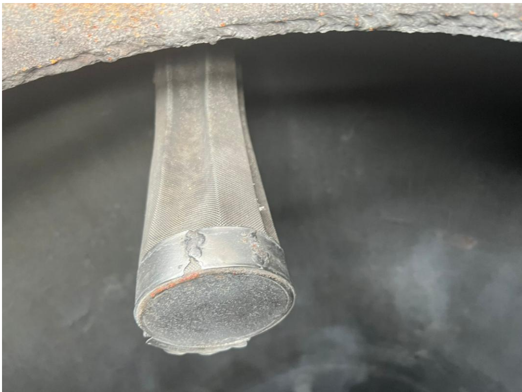
Instalación de malla superior N°30
