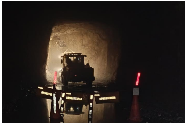
Figura 37 Desate de rocas mecanizado, con equipo Scaler.
