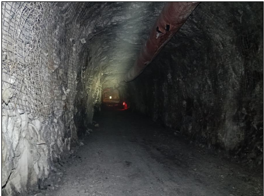
Sección de labor CN3 AC 161, más controlada con nuevo diseño de malla de perforación propuesto.
