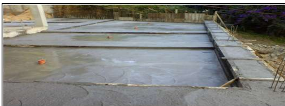
Figura 6. Asentamiento y sangrado
