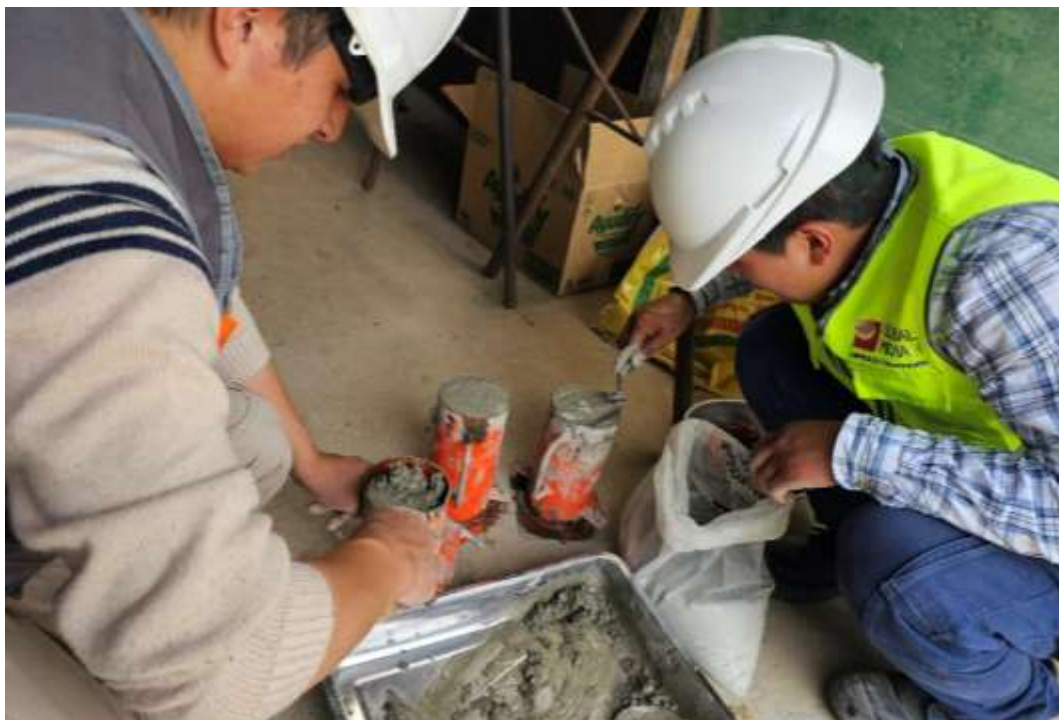
Fotografía 46. Empezamos a llenar los moldes de 10 cm x 20 cm con el concreto experimental mezclado para obtener probetas y hacer posteriormente los ensayos de compresión, tracción y flexión.
