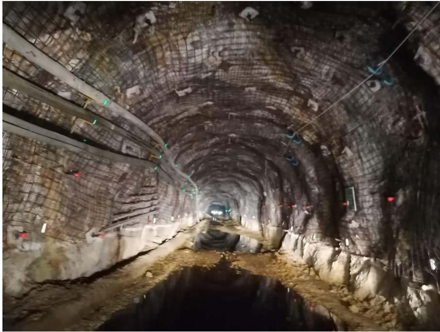
Fotografía N° 007: Vista de labores con sostenimeinto en Compañía Minera RAURA
