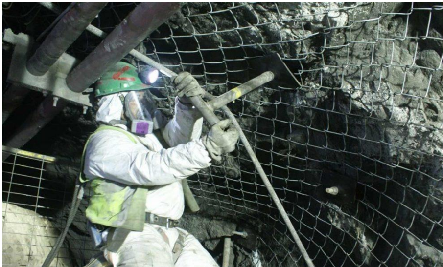
Fotografía N° 008: Vista de labores con sostenimeinto en Compañía Minera RAURA
