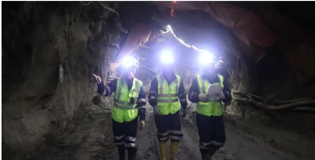
Fotografía N° 001: Vista de labores con sostenimiento en Compañía Minera RAURA
