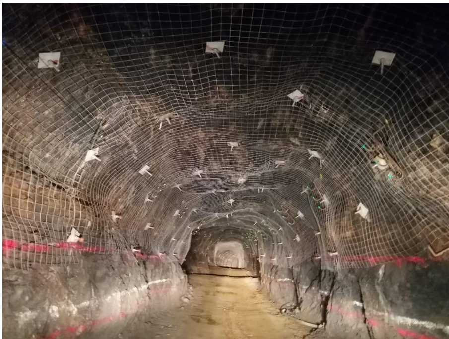
Fotografía N° 006: Vista de labores con sostenimeinto en Compañía Minera RAURA
