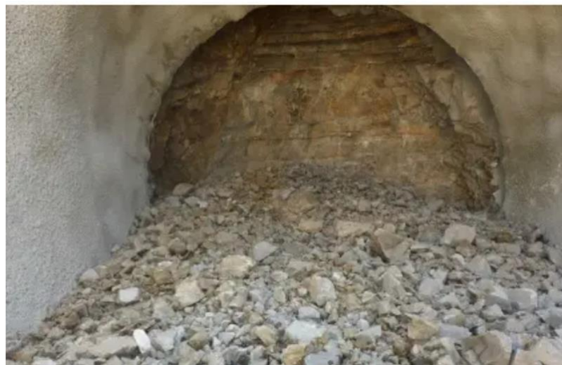
Figura 12. Roca fragmentada después de la voladura
