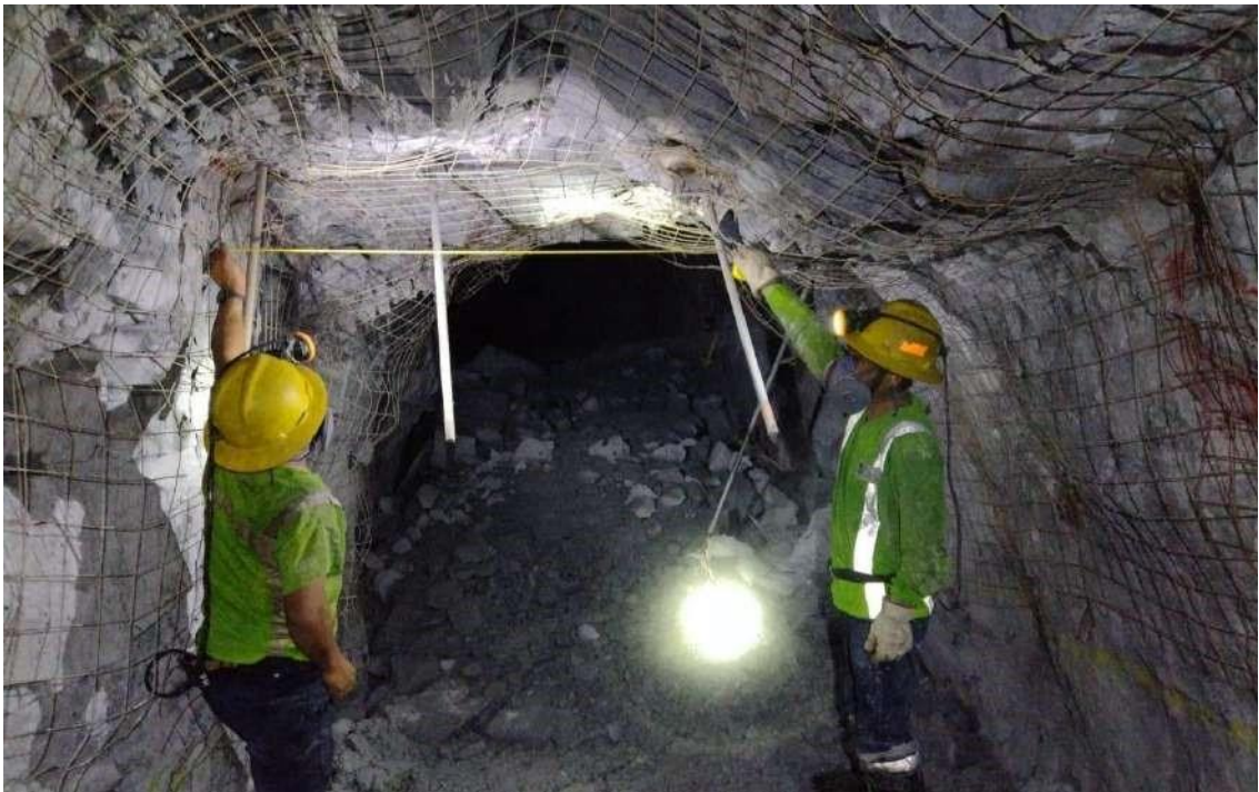
Anexo 19. Medición de la Caja Techo Posterior al Sostenimiento con Mallas y Split Sets
