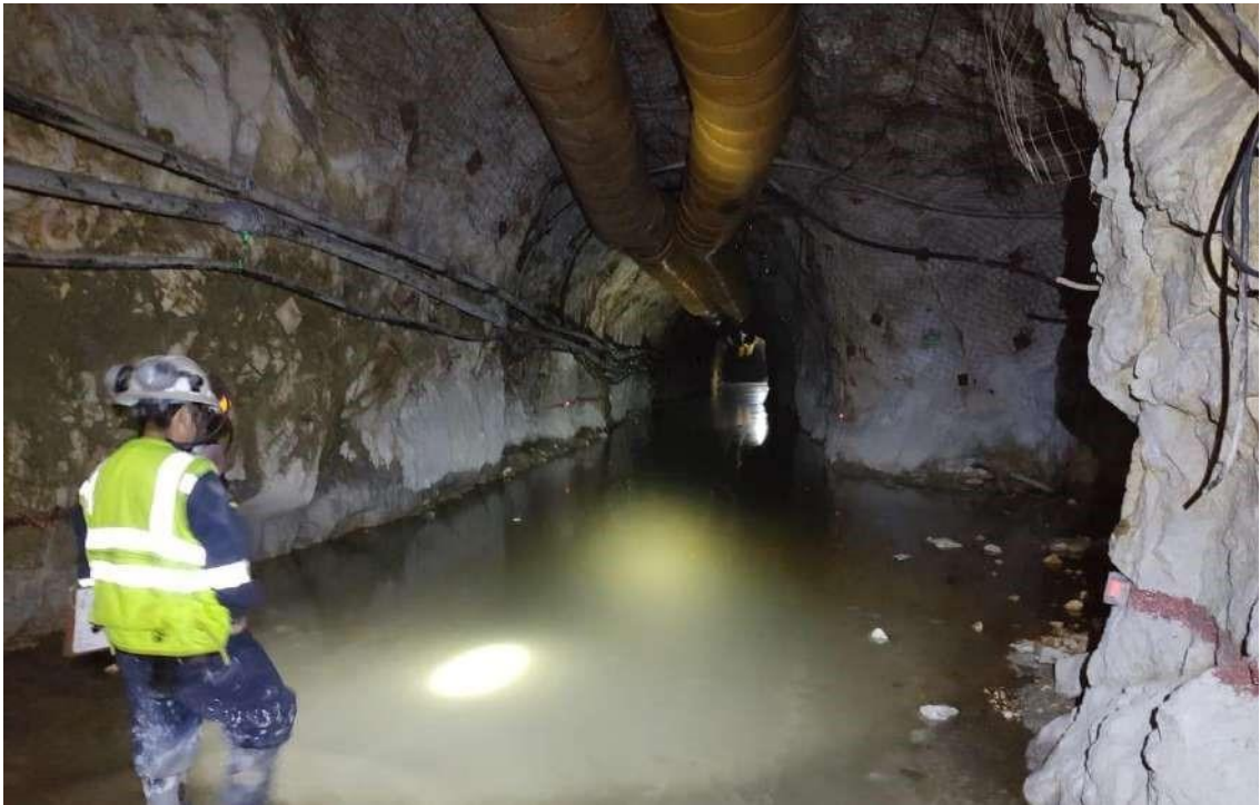
Anexo 18. Ingreso del CX 350 (Toromachay) Dado Que en el Lugar se Encuentra Una Poza de Bombeo Que Había Quedado Inoperativo.
