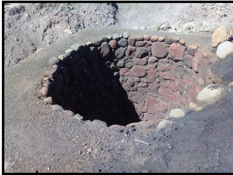
**Figura 21** - Parte superior Horno Artesanal sin material
