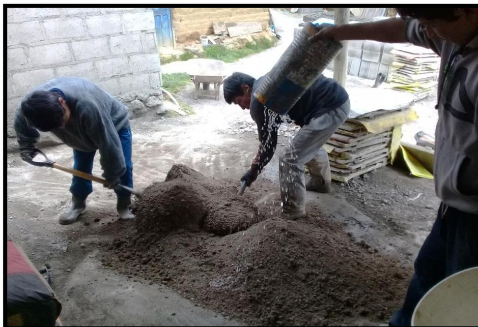
*Proceso de mezclado para la fabricación de bloques de concreto*
