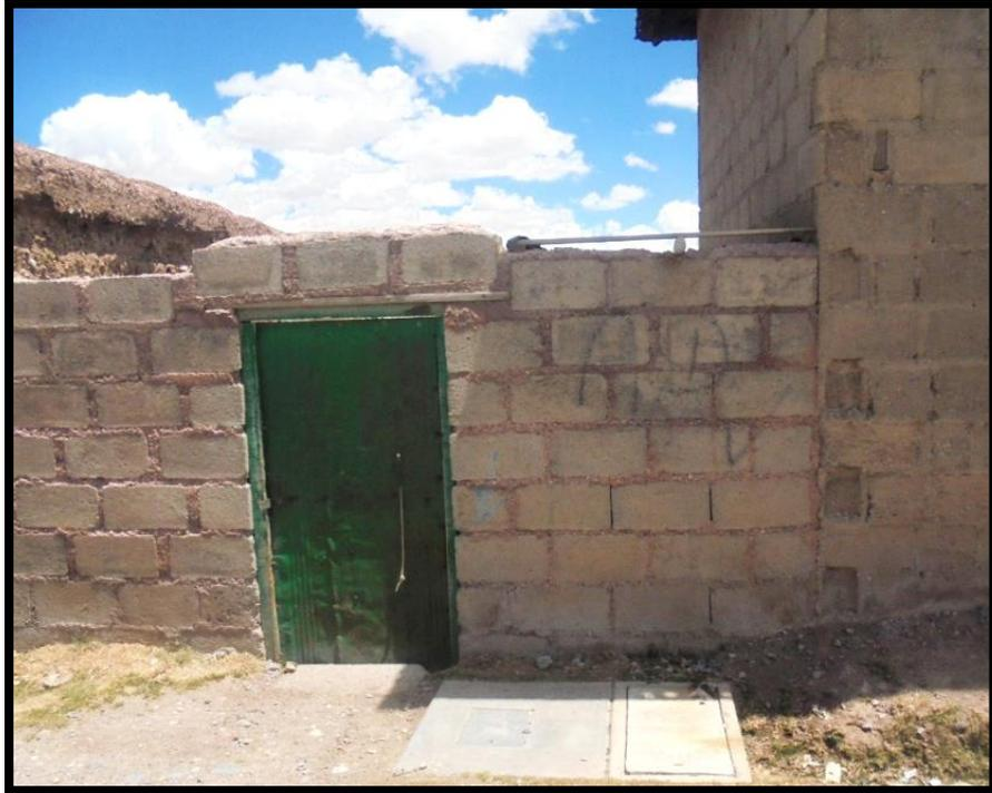
**Figura 32** - Ceniza de Cal utilizado como agregado para mortero de muros de albañilería con Bloques de Concreto
