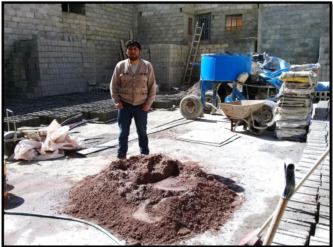
**Foto N°13 - Saturación 24 horas de Ceniza de Cal 2 para Fabricación de Bloques**
