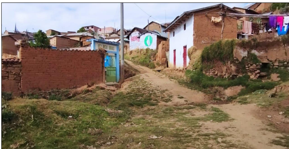
Figura 40. Viviendas ocupadas al área de influencia del proyecto.
