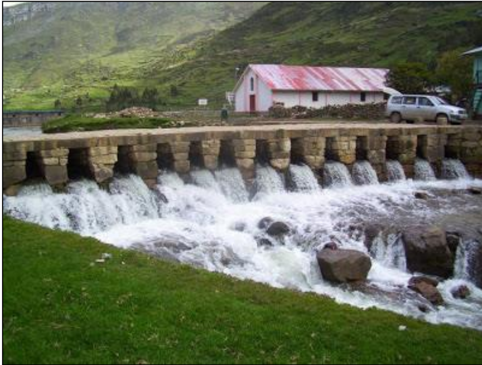
Figura 1. Puente de piedra incaico - Qhapaq Ñan
