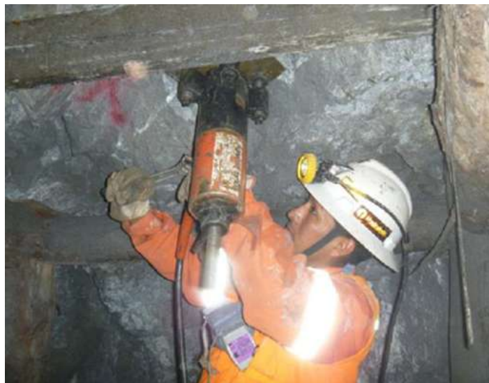
Figura 36 Instalación del equipo Bolt Test
