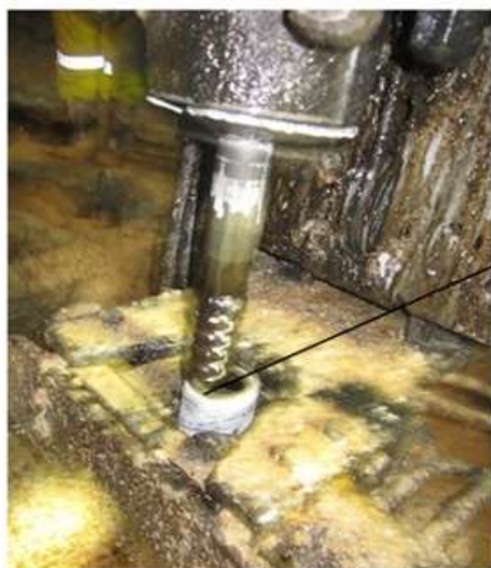
Figura 79 Mal desembonado de la barra
