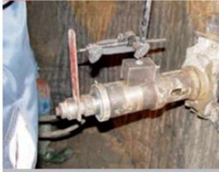
Figura 37 Ejecución de la prueba con el Pull Bolt
