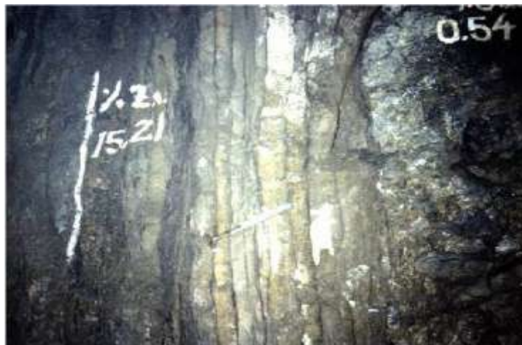
Figura 6 Alto nivel de fracturamiento
