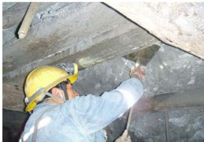
Figura 32 Instalación de los pernos Omega-Bolt®
