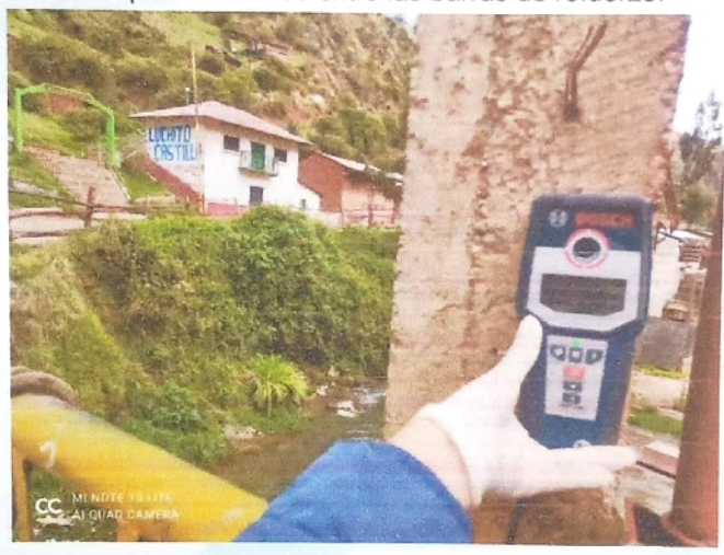
Imagen N°06. Detección de acero
