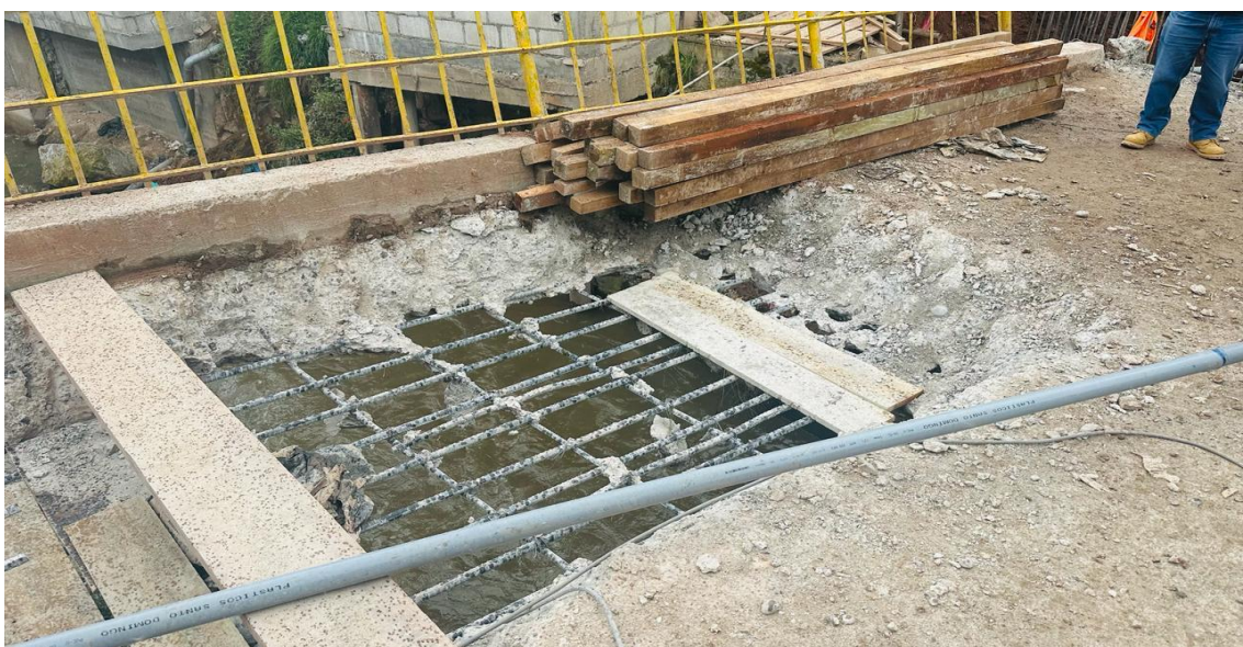
Ilustración 2: Demolición controlada en puente (Fuente: Propio)
