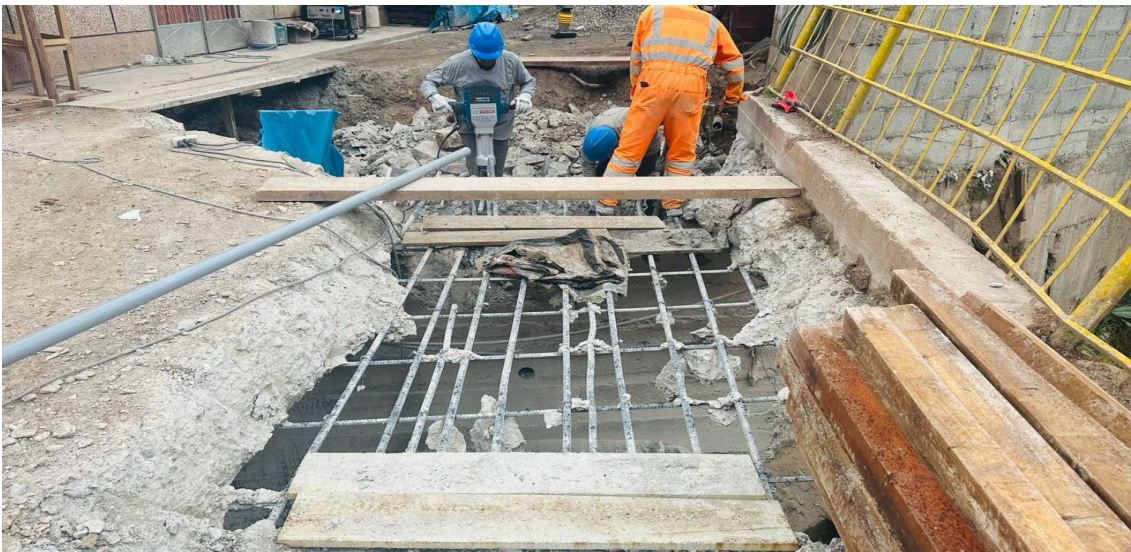
Ilustración 2: Demolición controlada en puente (Fuente: Propio)
