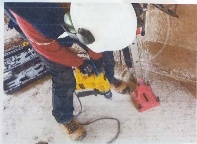
Imagen N°07. Perforación para anclaje de equipo
