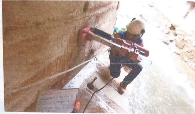
Imagen N°08. Anclaje del taladro diamantino
