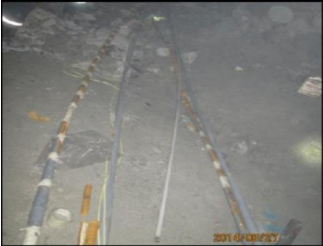
Preparación de los tubos con la carga explosiva
