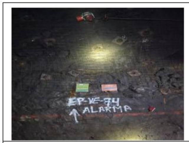
Figura 36. Dispositivo sonoro en caso de falla eléctrica y/o mecánica del ventilador EP-VE-74
