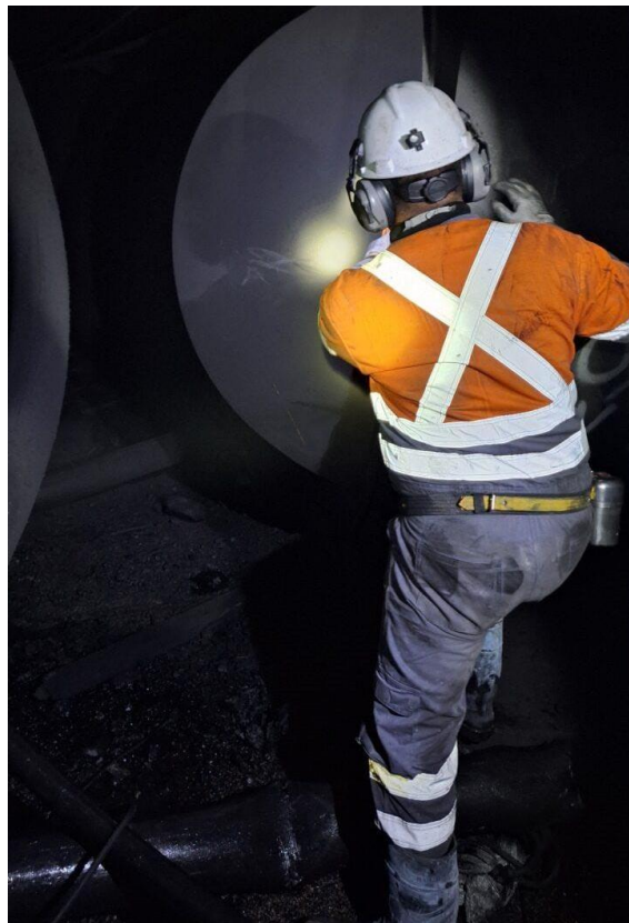
Fotografía 4: Coordinación de maniobra de ventilación y revisión de alarmas
