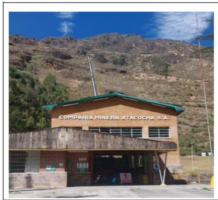
Figura 5. Central Hidroeléctrica Chaprin
