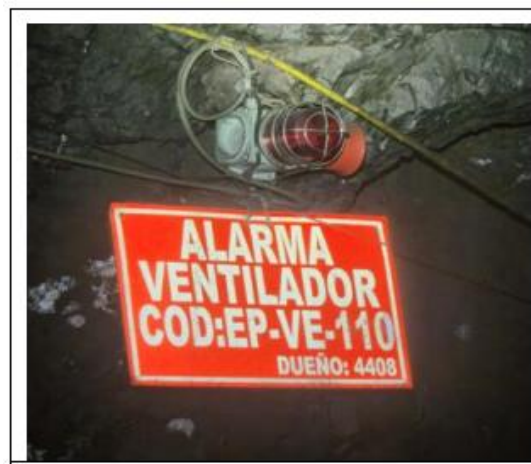
Figura 21. Dispositivo sonoro eb caso de falla eléctrica y/o mecánica del ventilador EP-VE-110
