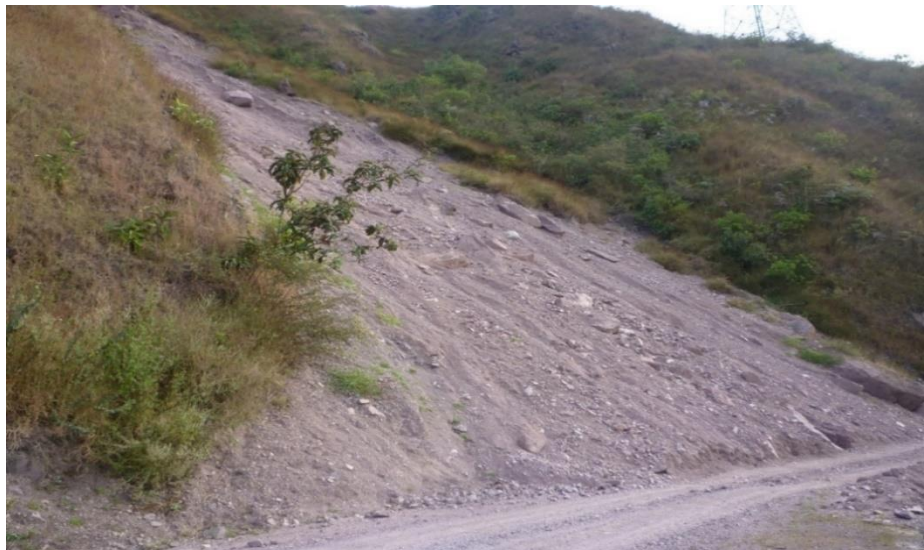
Figura 19: Talud con 75 a 90 % de Inclinación.
