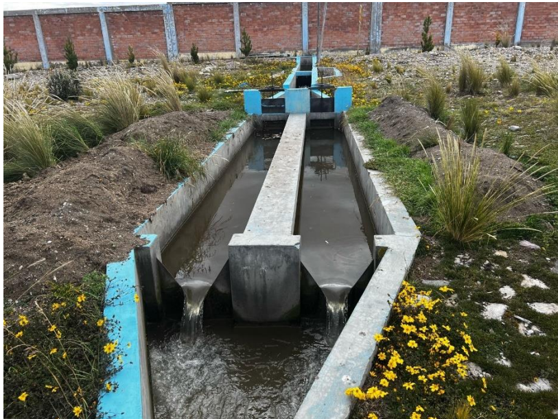
Gráfico 5. Canal Parshall para medir el Caudal
