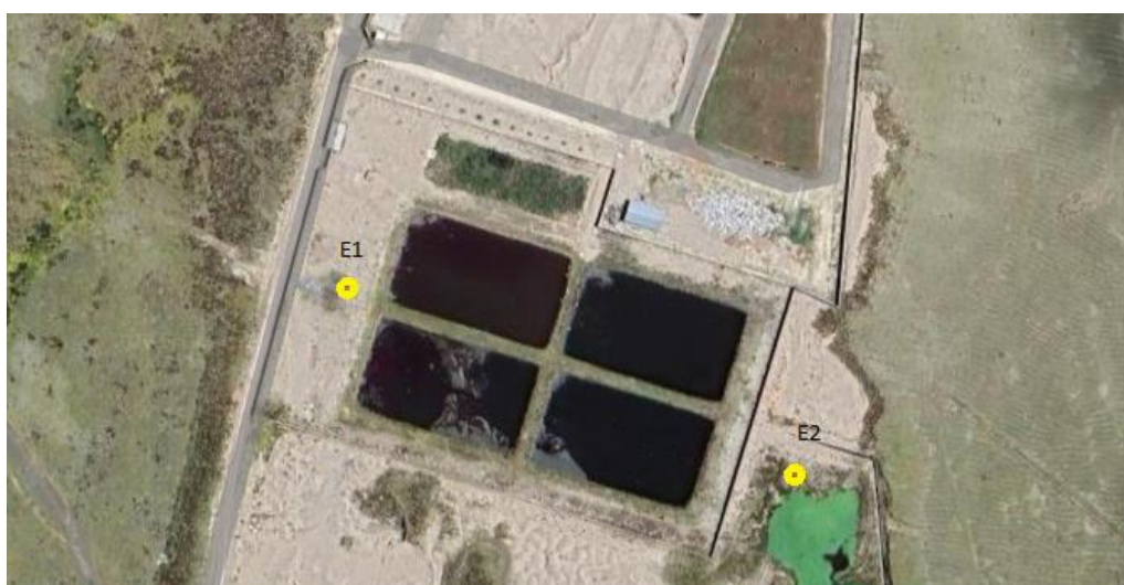
Gráfico 1. Planta de tratamiento de Agua Residual de Ninacaca
