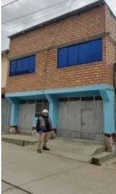
Vista 1: Estructura de una Edificación Común en la Zona de Estudio
