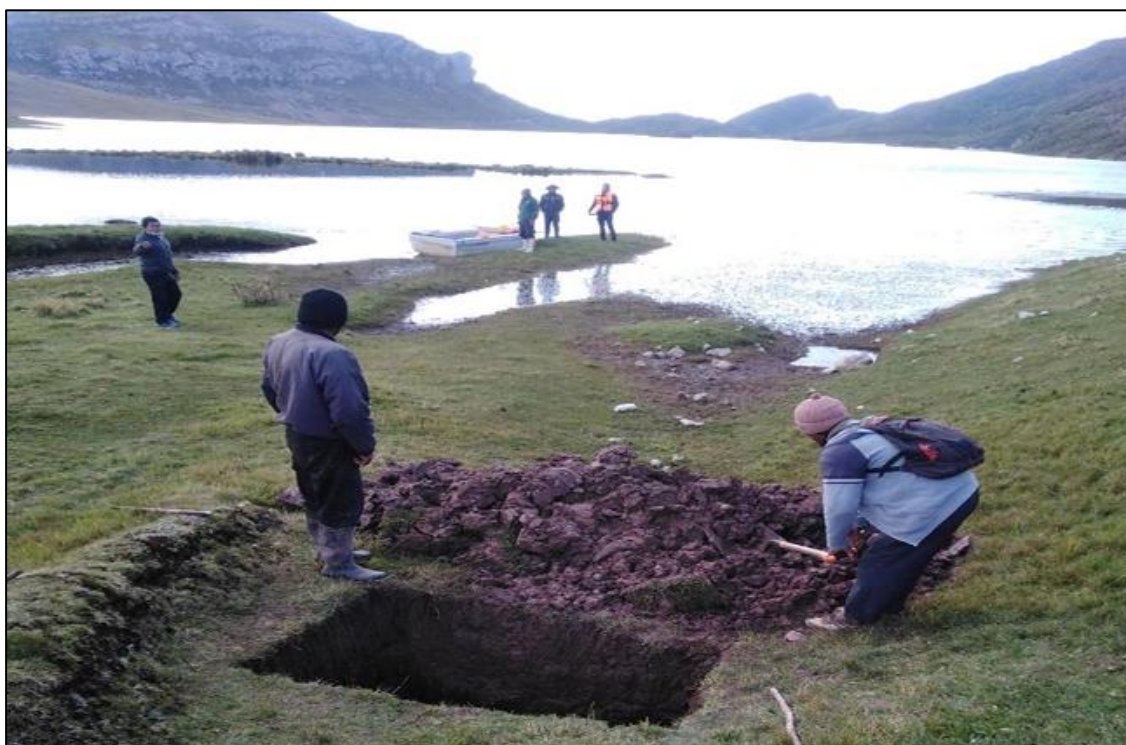
Exploración de la zona de captación de las aguas para el sistema de riego
