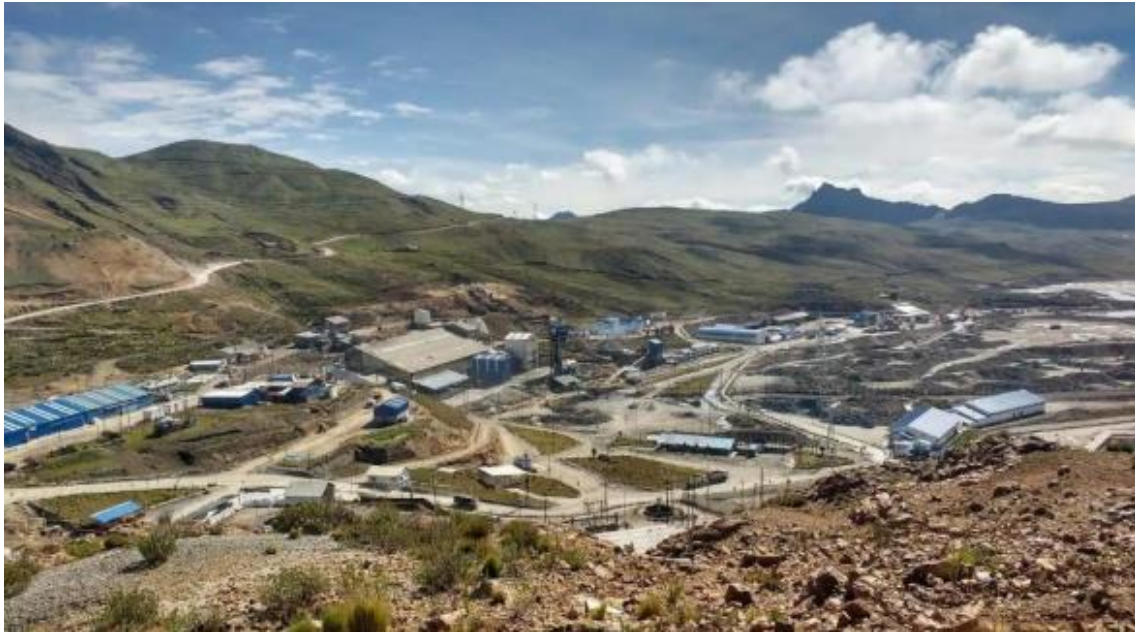
Fotografía 1. Vista panorámica de la empresa minera Pan American Silver – Unidad Huaron
