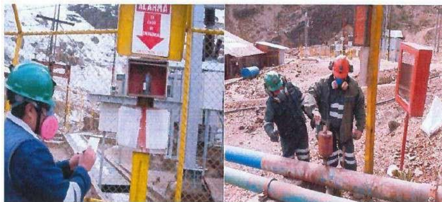
Sistema de alarma odorífica Bocamina Carlos Francisco Nv. 1700
