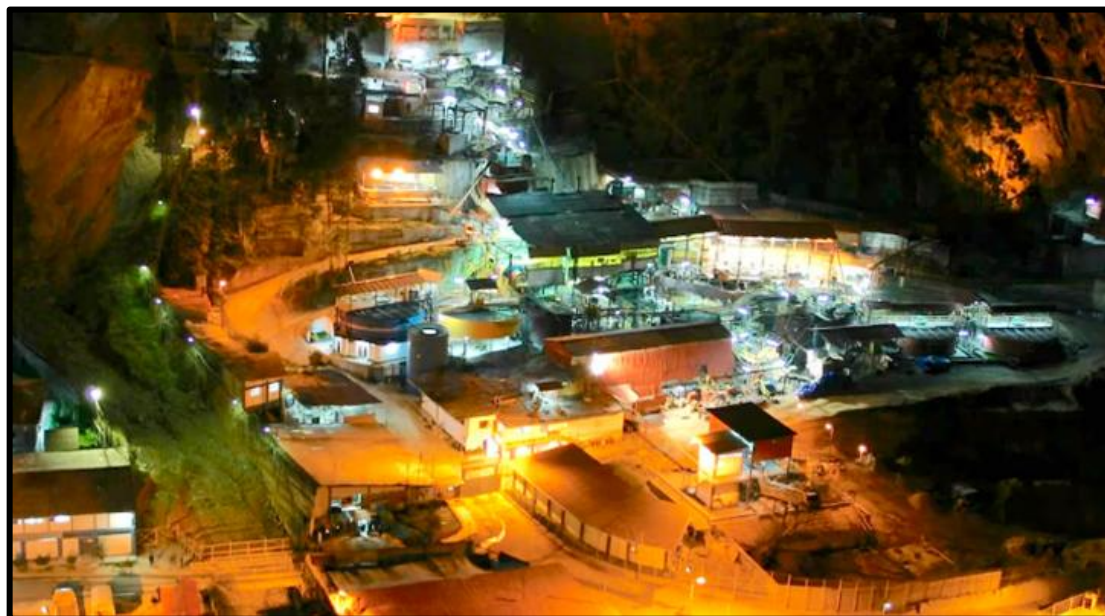
Figura 1. Vista panorámica de las Unidad Minera Parcoy
