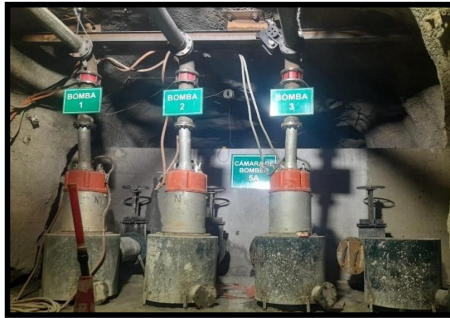
Figura. 11. Poza de sedimentación y bombeo.
