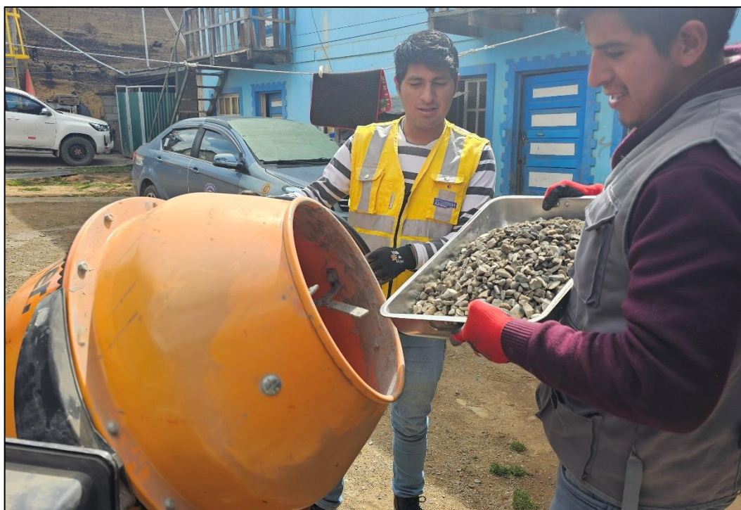
Fotografía 11. Realizamos la mezcla del concreto, llamado patrón A para comparar posteriormente con los diseños experimentales.
