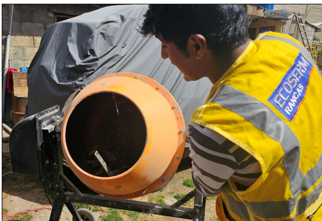
Fotografía 12. Realizamos la mezcla del concreto, llamado patrón A para comparar posteriormente con los diseños experimentales.
