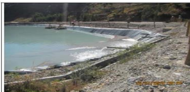
Fotografía N° 63. Vista de la poza de sedimentación N° 1, se observó material sedimentado y espejo de agua, asimismo era alimentada por 4 tuberías de HDPE de 6" y 2 barcas mediante los cuales se realizaba la floculación de las aguas.
