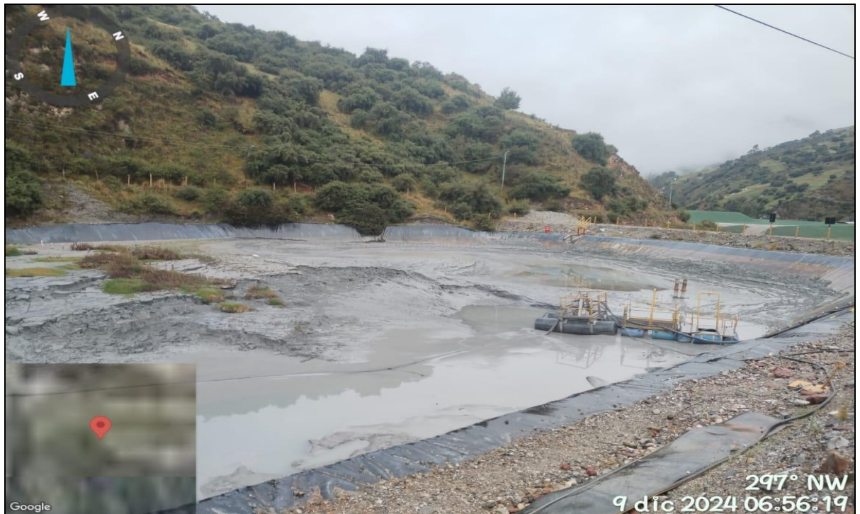
Fotografía N° 001: Imagen de las pozas de sedimentación, donde falta de mantenimiento
