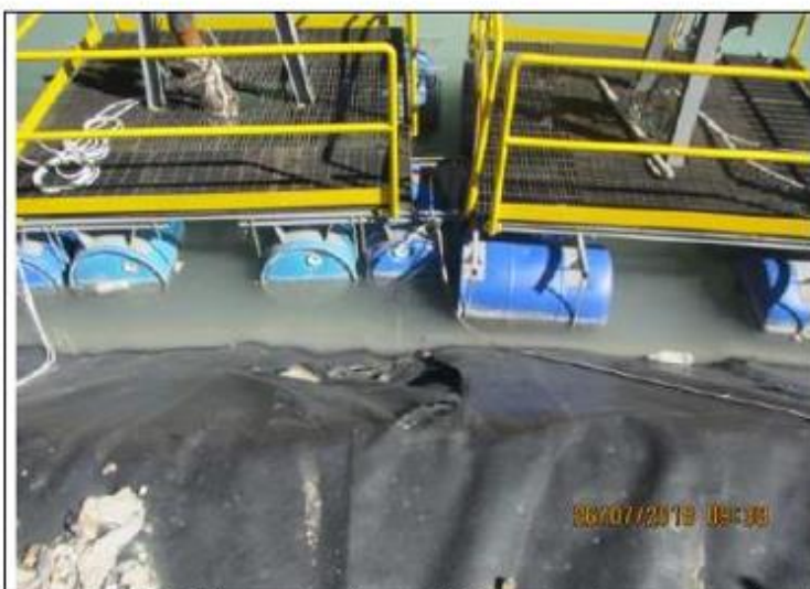
Fotografía N° 64. En la poza de sedimentación N° 1 se observó que la geomembrana impermeabilizante se encontraba rota en un área aproximada de 1,3 metros cuadrados.
