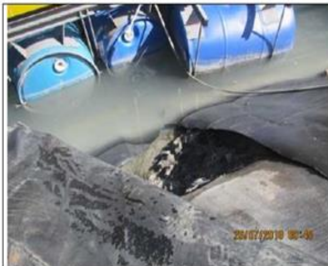
Fotografía N° 65. En la poza de sedimentación N° 1 se observó que la geomembrana impermeabilizante se encontraba rota en un área aproximada de 1,3 metros cuadrados, asimismo el agua contenida en la poza de sedimentación tenía contacto con el suelo que estaba debajo.
