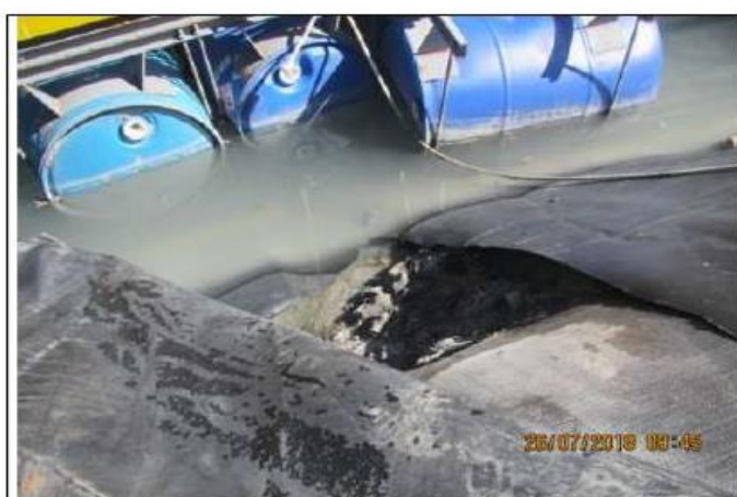
Fotografía N° 65. En la poza de sedimentación N° 1 se observó que la geomembrana impermeabilizante se encontraba rota en un área aproximada de 1,3 metros cuadrados, asimismo el agua contenida en la poza de sedimentación tenía contacto con el suelo que estaba debajo.
