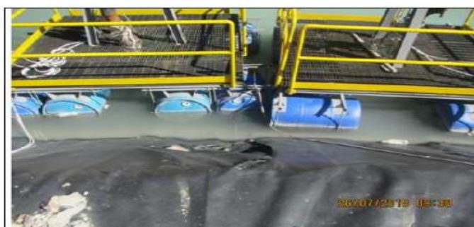
Fotografía N° 64. En la poza de sedimentación N° 1 se observó que la geomembrana impermeabilizante se encontraba rota en un área aproximada de 1,3 metros cuadrados.
