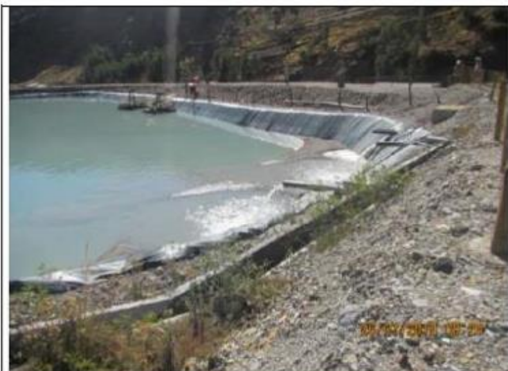
Fotografía N° 63. Vista de la poza de sedimentación N° 1, se observó material sedimentado y espejo de agua, asimismo era alimentada por 4 tuberías de HDPE de 6" y 2 barcas mediante los cuales se realizaba la floculación de las aguas.
