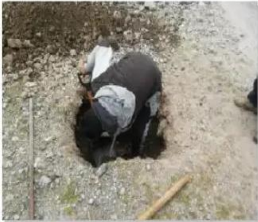
Vista: Excavación de Calicata
