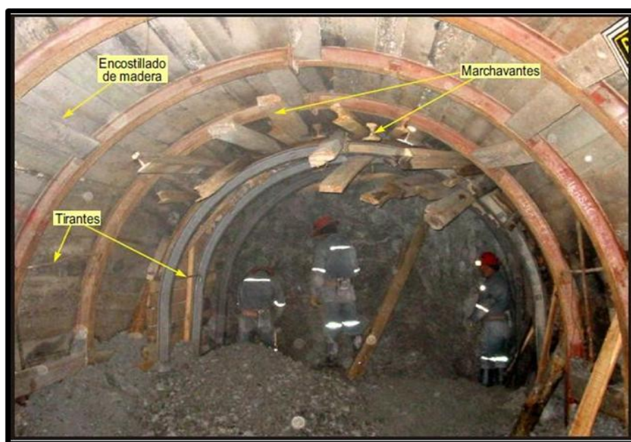
Figura 10 Instalación de cimbras
