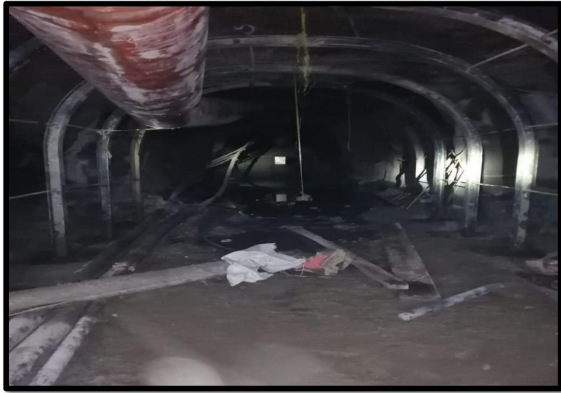
Sostenimiento con cimbras metálicas
