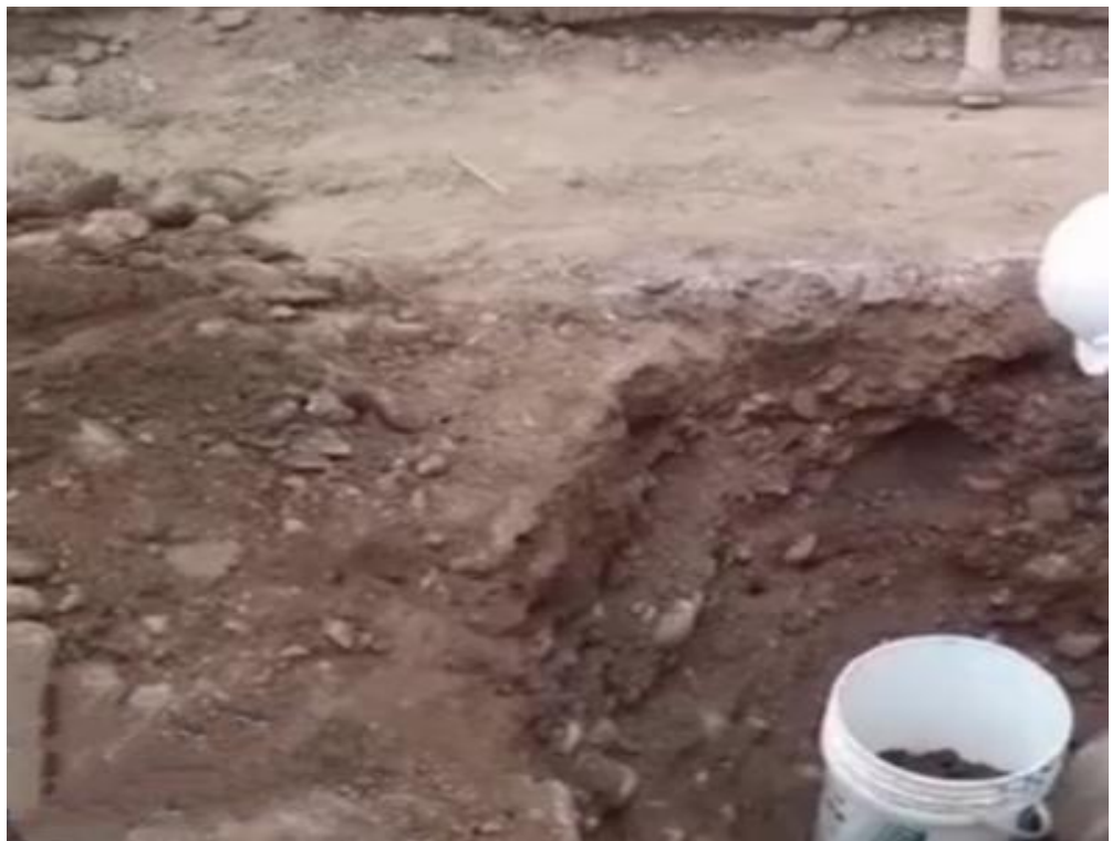
Imagen 2. Excavación de calicatas
